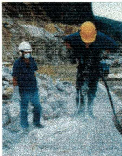
Figura 3.1: Perfuração da Rocha
