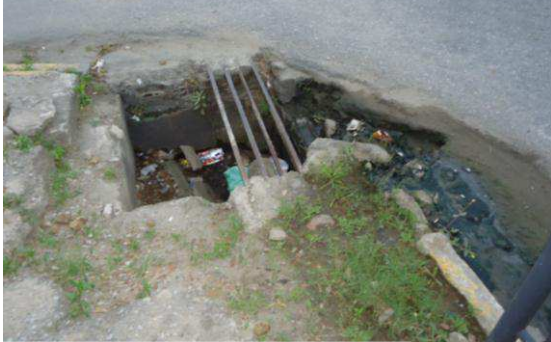
Figura 7 – Boca de lobo na lateral do IC-CG.
