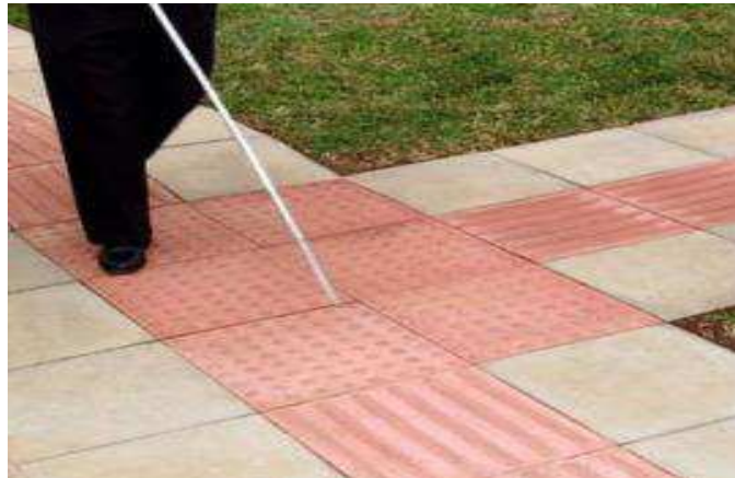
Figura 3 – Sinalização com piso tátil do tipo alerta e direcional
