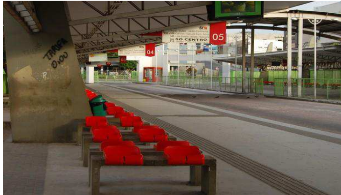
Figura 5 – Sinalização do tipo piso tátil no terminal de Integração.
