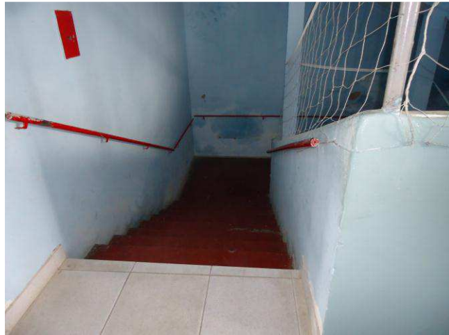
Figura 11 – Escadas no interior do IC-CG.
