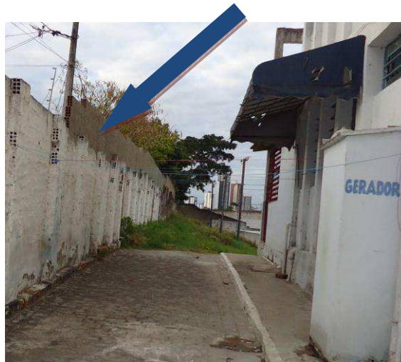
Figura 10 – Obra realizada para levantar o muro no IC-CG.
