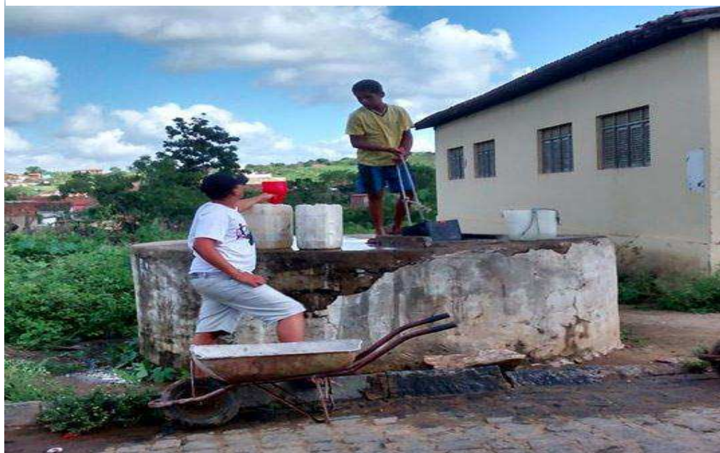
Figura 3: Cisterna pública na comunidade de Boa Vista (Micoárea 04)
