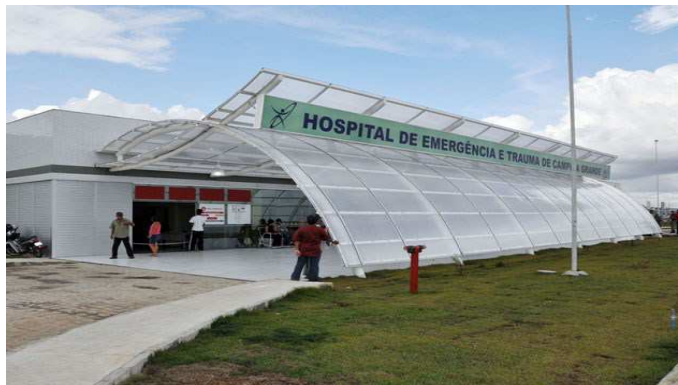
Figura 2 - Hospital de Emergência e Trauma de Campina Grande.
