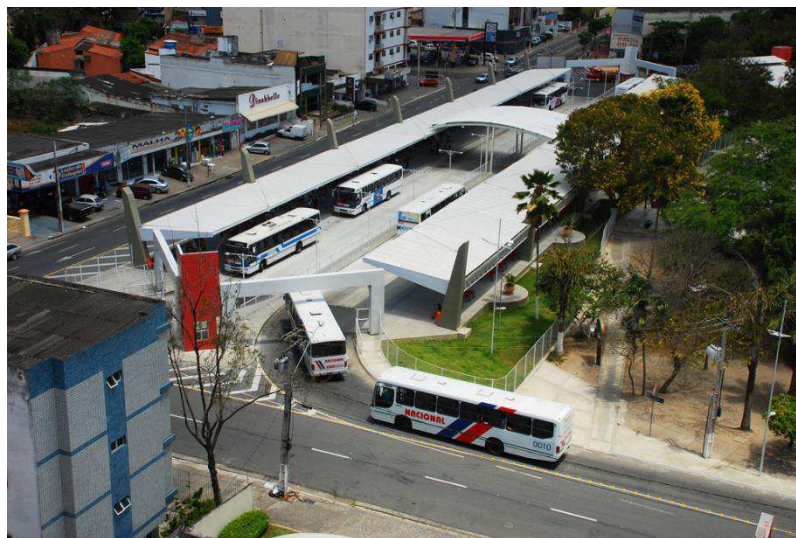
Figura 9 - Terminal de integração, construído bem na frente do museu Assis Chateaubriand. Fonte: http://www.valemaiscard.com.br/ Acesso em: Julho, 2016.
