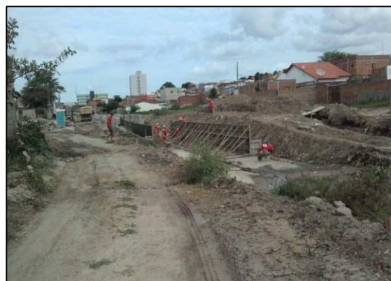
FOTO 09 – OBRAS EM CONTINUIDADE. AUTOR: CARDOZO, Kátia P., 2016.
