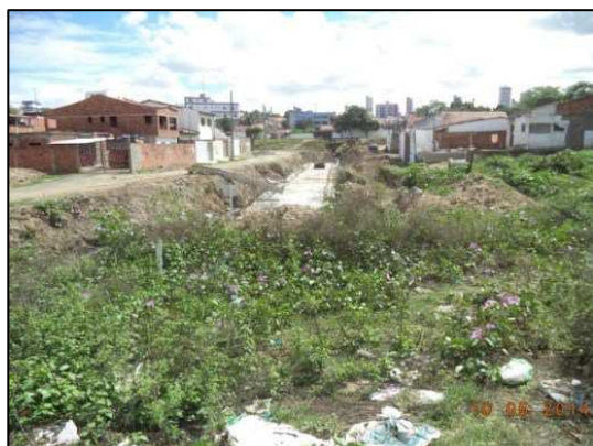
FOTO 10 – O LEITO DO CANAL SENDO ESTRUTURADO. AUTOR: CARDOZO, Kátia P., 2014.
