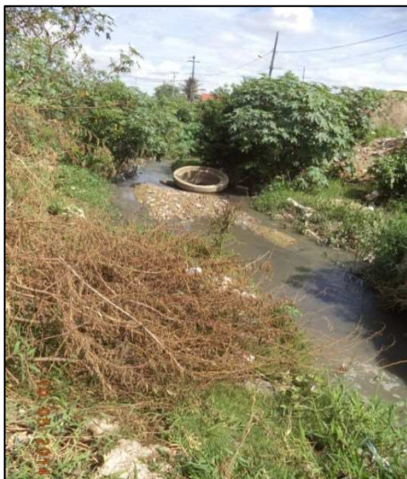
FOTO 06 – ACÚMULO DE LIXO E ENTULHOS NO LEITO DO CANAL DE SANTA ROSA. AUTOR: CARDOZO, Kátia P., 2014.
