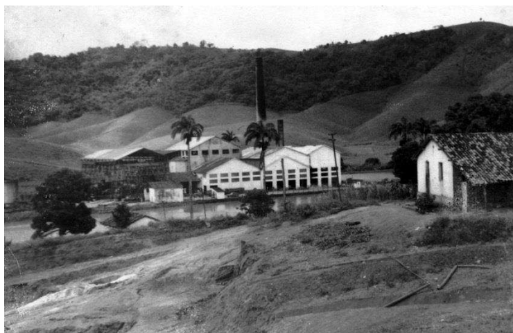
FIGURA 36: Usina Tanques. AUTOR: NASIASENE, 1979.
