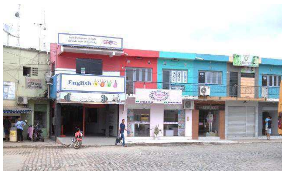
FIGURA 02: Galeria Comercial na Rua Padre Belísio. AUTOR: MARQUES, 2017.
