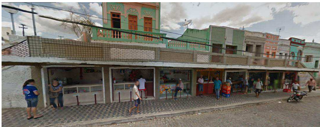
FIGURA 14: Boxes do antigo Terminal Rodoviário no CTAG. AUTOR: WANDERLEY, 2016.
