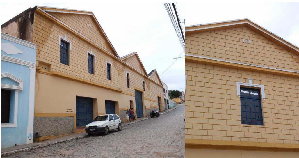
FIGURA 26: Armazéns construídos pela empresa Wharton Pedroza. AUTOR: MARQUES, 2017.
