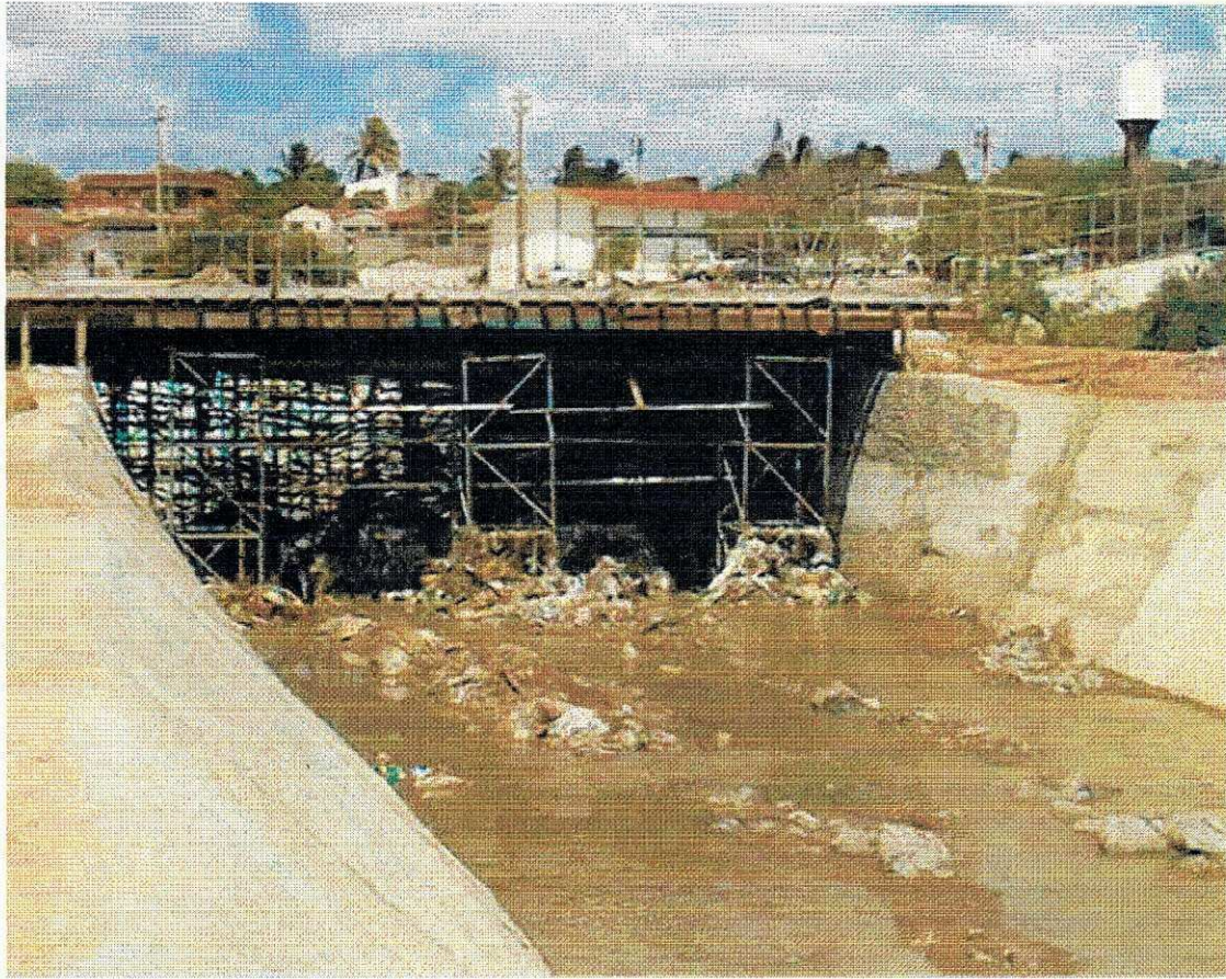
Imagem 06 - escoramento da ponte
