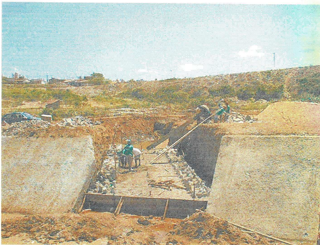
Imagem 03 - execução do sub-canal
