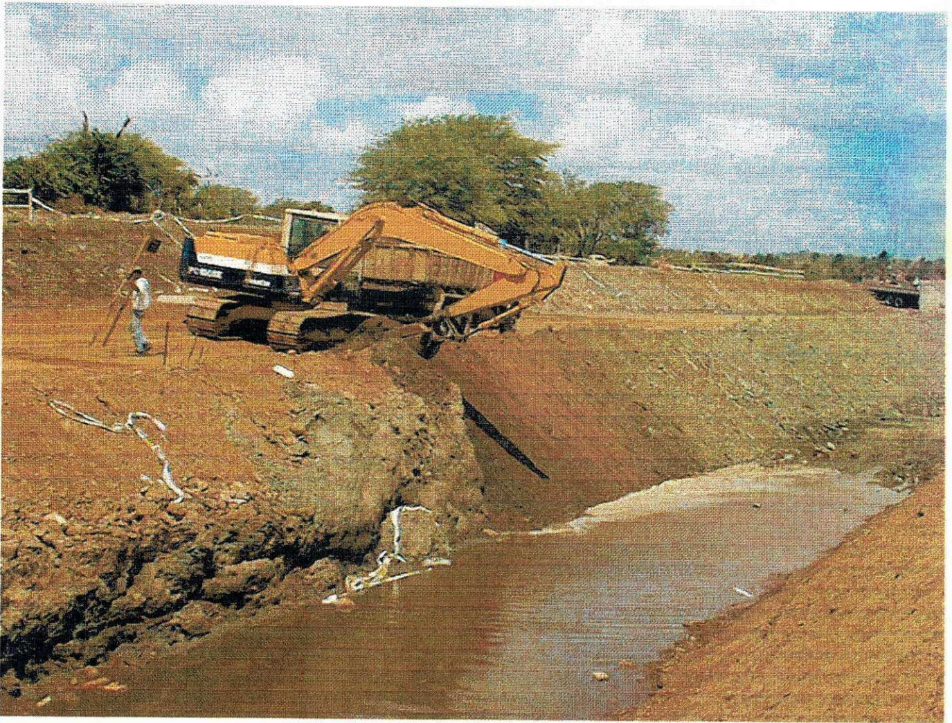
Imagem 02-vista geral da escavação das paredes do canal
