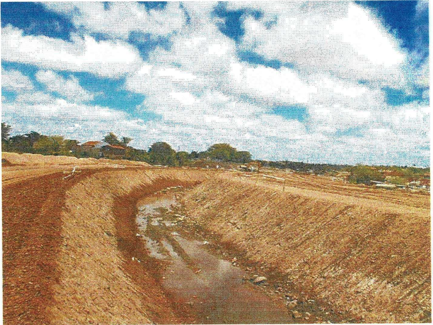
Imagem 01-vista geral da escavação do canal
