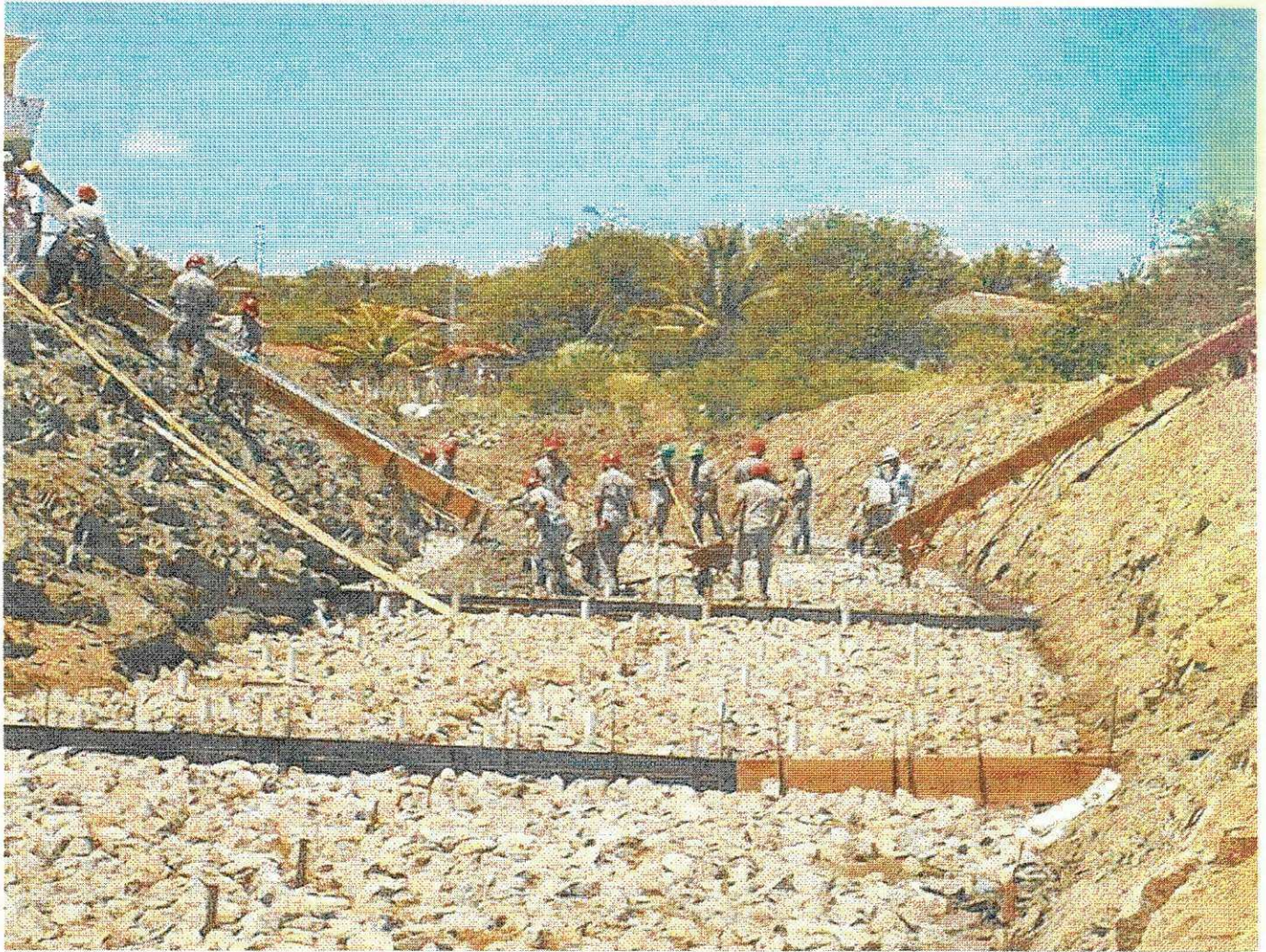
Imagem 09-concretagem do piso do canal
