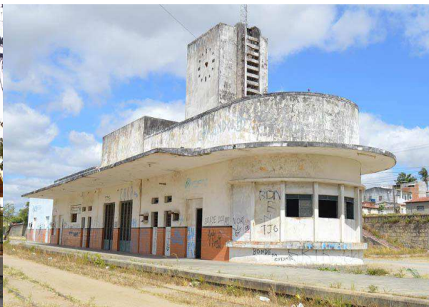
Figura 5B: Estação Ferroviária do Centenário, CG – PB.
