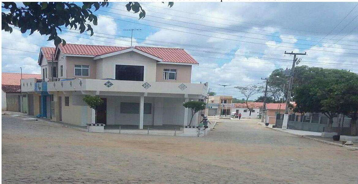
Figura: 09: Centro da sede do município de Barra de Santana.
