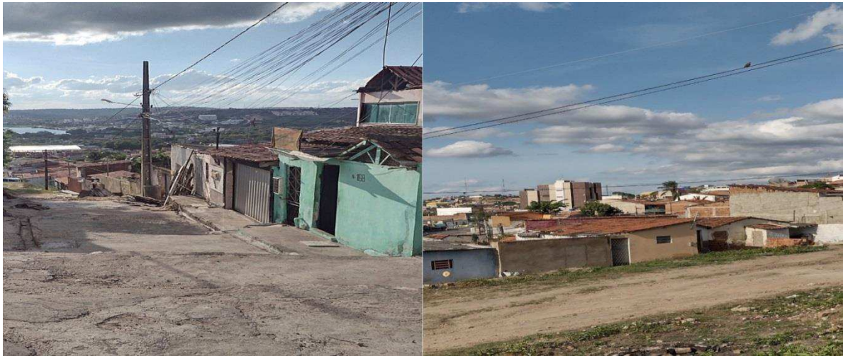
Figura 9: Construções inadequadas na Rua Capitão João Alves de Lira.
