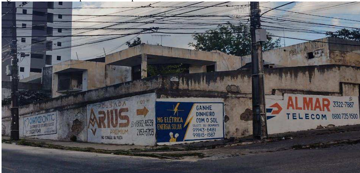
Figura 5: Imóvel desocupado na Rua Cap. João Alves de Lira.
