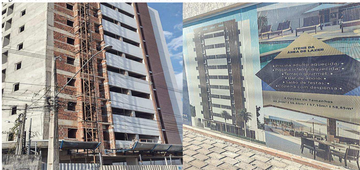
Figura 6: Canteiro de obras e standart do novo condomínio Alta Vista Premium
