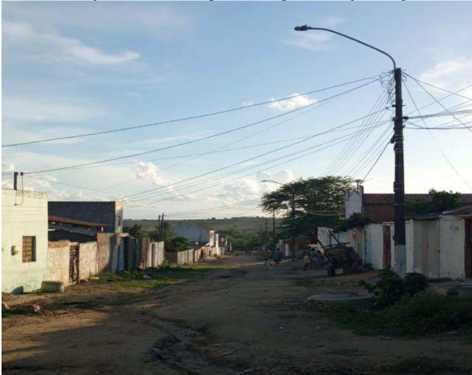
Figura 03 – Rua do Conjunto Mutirão desprovida de pavimentação e esgotamento sanitário
