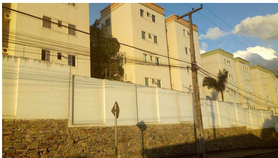
Fig. 09: Parte lateral do Residencial Dona Lindu. Fonte: Própria, Out. 2017
