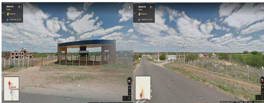
Figura 8: Terreno do CDSA em 2012, prédios ainda em processo de construção. Fonte: Google maps, setembro de 2017.
