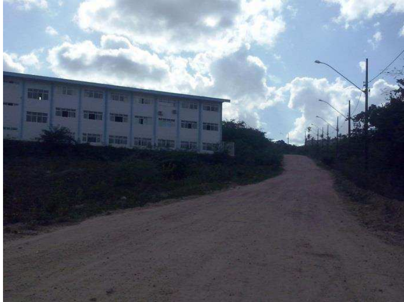
Foto 4: Rua Manoel Tenório de Souza – Bairro Universitário
