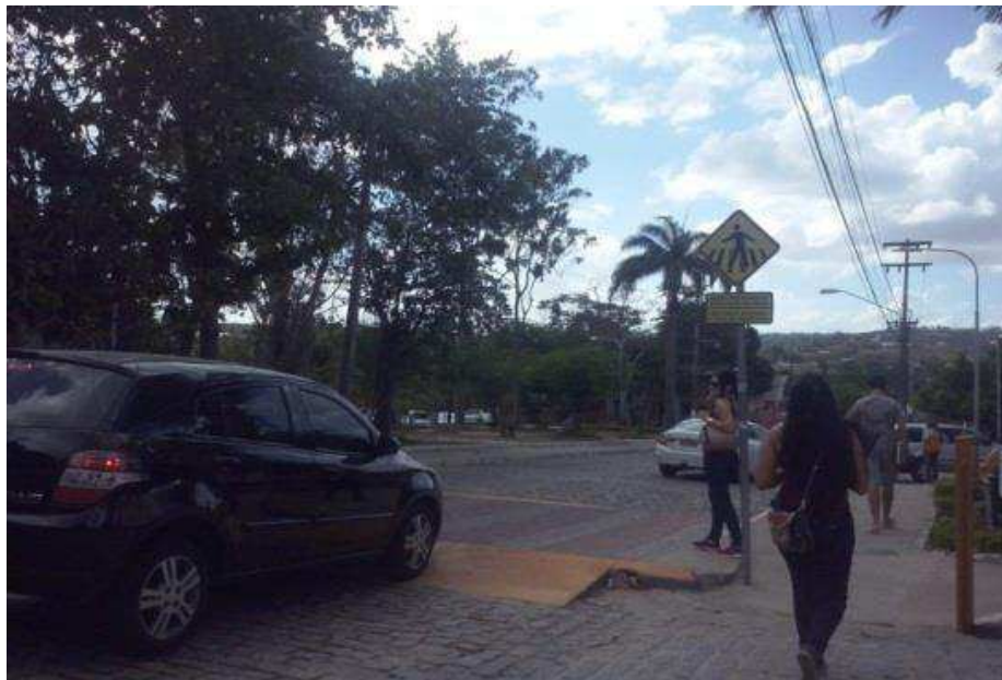
Foto 14: Faixa para pedestre com elevação dentro do Campus da UFCG
