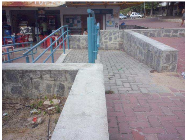
Foto 15: Rampa para melhor mobilidade e acessibilidade no Campus da UFCG
