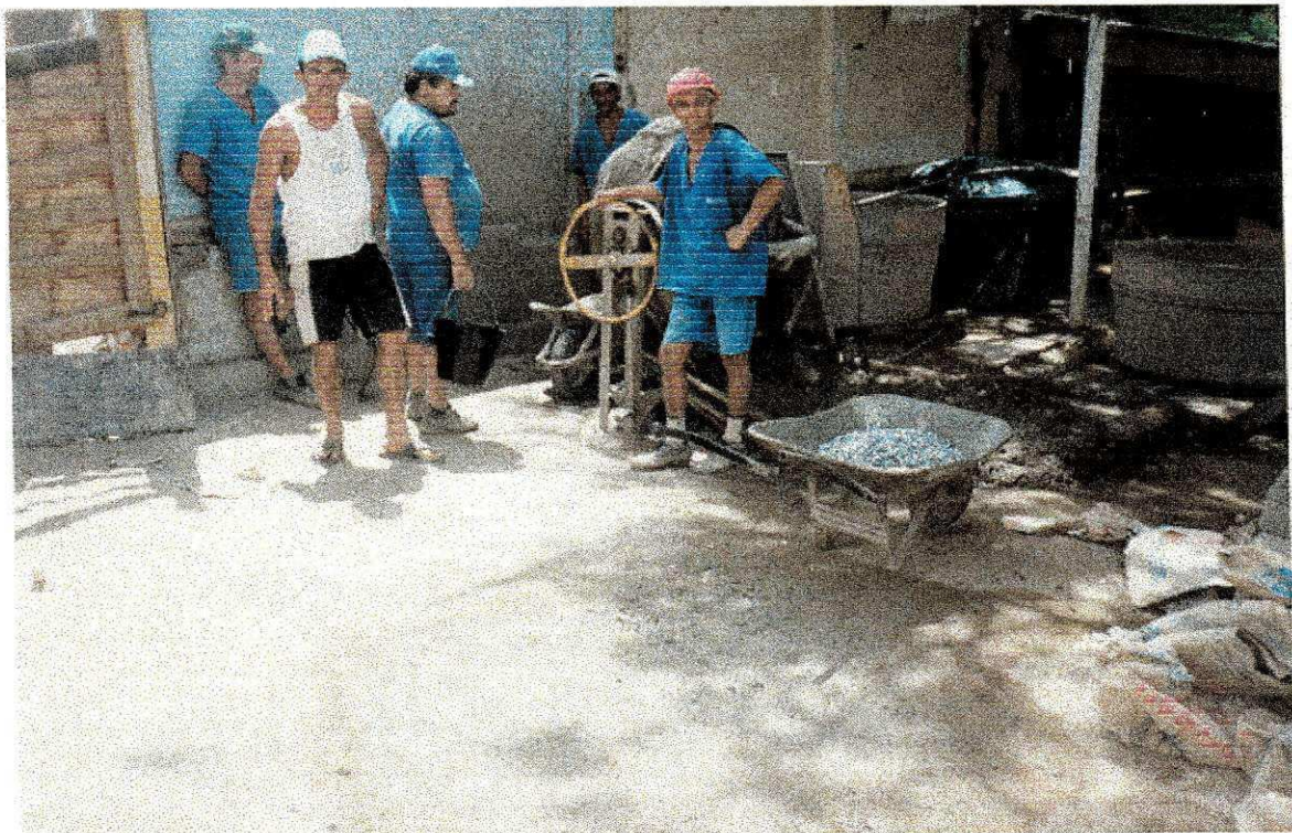
Foto 6 – Preparo de argamassa e do concreto, bem como flagrante da não utilização de capacetes na obra
