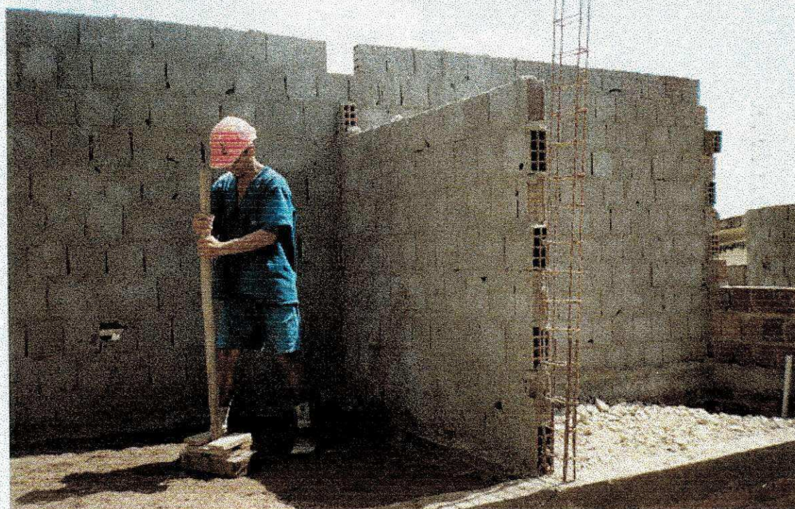
Foto 3 – Mostra o aterro e apiloamento do caixão em um dos boxes
