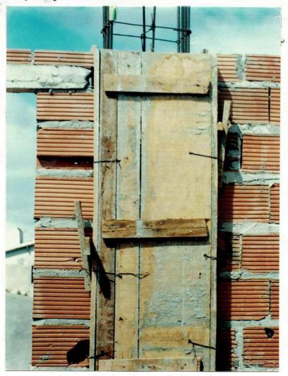
Utilizou-se nas aberturas da alvenaria, janelas e portas, um reforço através da adoção de vergas, que foram confeccionadas "in loco" e apoiadas em 20 cm, no mínimo, nas laterais, levando-se em consideração o vão.
