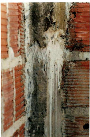
Por ser uma obra particular a economia se fez presente. As fôrmas utilizadas nas vigas e pilares foram de madeira agreste, de 23cm e 30cm de largura e 2,5cm de espessura, reutilizadas várias vezes e às vezes emendadas lado a lado, amarradas à alvenaria com arame recozido, sendo devidamente
