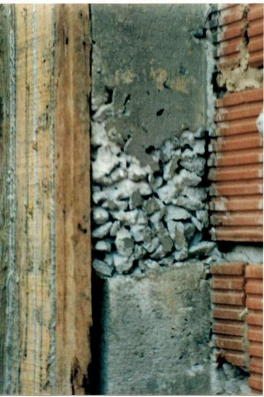
No encontro entre alvenarias havia um travamento entre os componentes de uma e outra parede. Foi feito uma ligação por amarração, uma vez que esta apresenta melhor desempenho por permitir a redistribuição das tensões atuantes na alvenaria. Neste caso, todas as juntas verticais entre os blocos que se interceptam e os blocos seguintes eram preenchidos.
