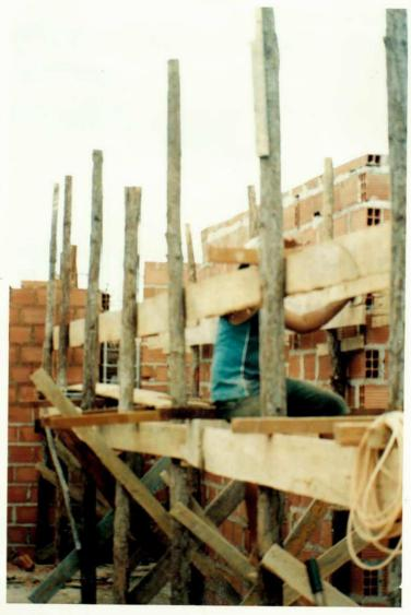
Todo o concreto das vigas e pilares se deu "in loco", transportado por carro-de-mão e lançado pelo operário através de balde. Fato não ocorrido com as lajes, que face ao grande volume, e pelo dueto economia, qualidade, optouse pelo usinado, lançado através de bomba para concreto.
