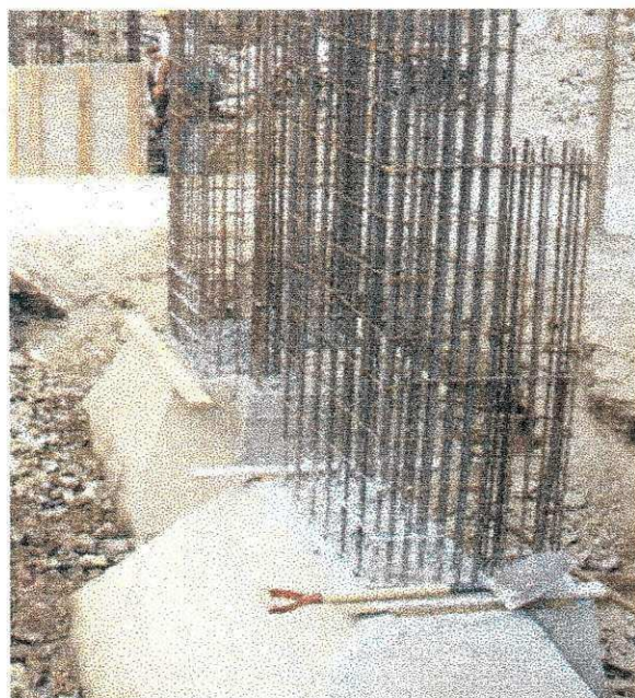
Fig. 01 – Sapata retangular já executada
