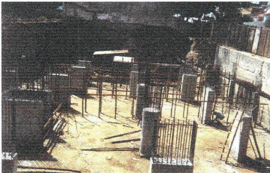
Fig. 03- Início do escoramento para base das vigas
