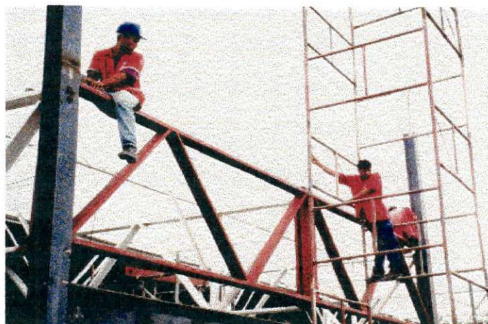
Foto 16 – Operários da Vão Livre executando a estrutura metálica da cobertura
