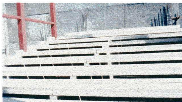
Foto 8 – Laje em painel CCA Sical
