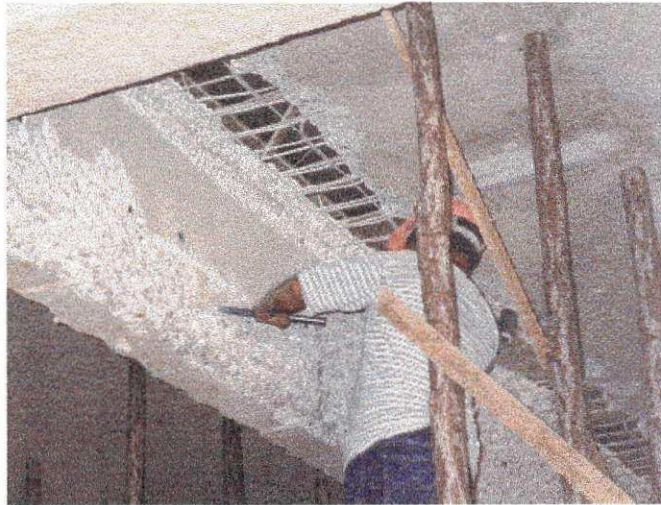
Fotos 11 e 12 – Reforço nas vigas
