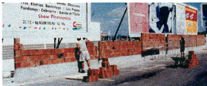
Foto 2 – Construção do muro do estacionamento "B"
