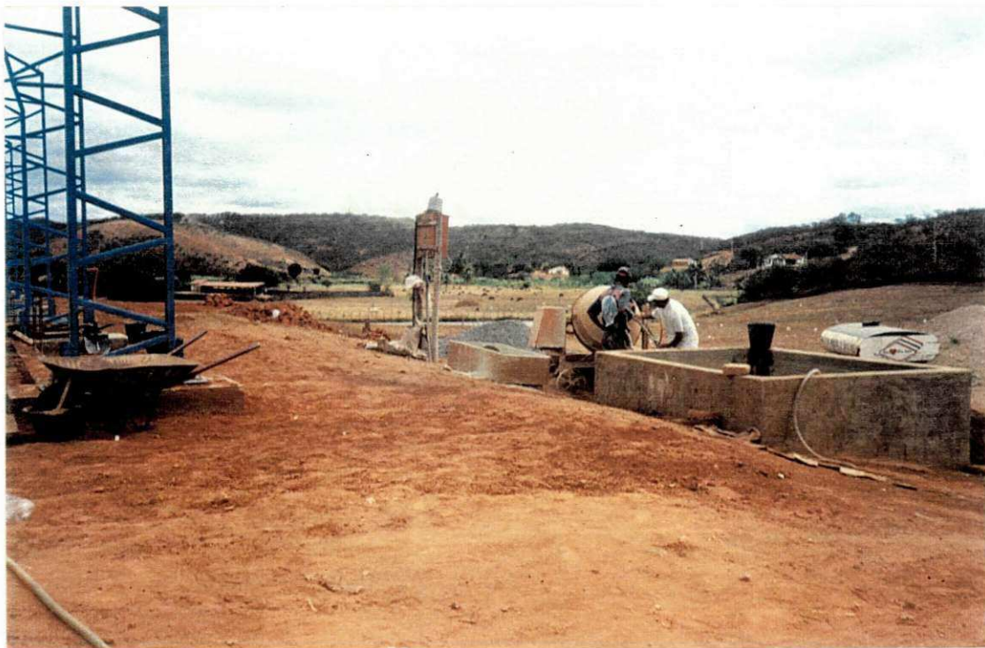
Fabricação do concreto utilizando a betoneira
