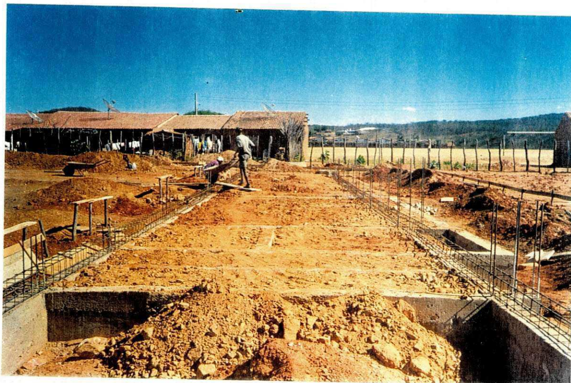
Transporte de material para aterrar e nivelar o ginásio para posteriormente executar o piso do ginásio
