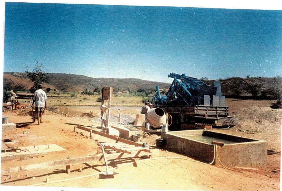
Chegada dos pilares metálicos
