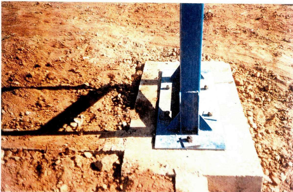
Pilar metálico encaixado na base de estrutura metálica o encaixe é feito através da junção porca-parafuso como mostra a foto acima
