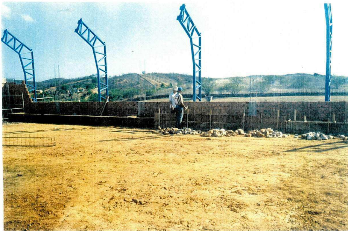
Levantamento da arquibancada utilizando alvenaria de pedra
