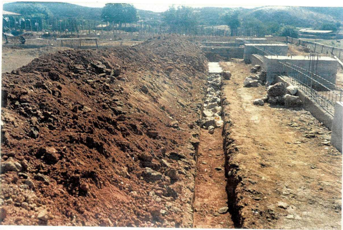
Alvenaria de pedra para o embasamento das arquibancadas
