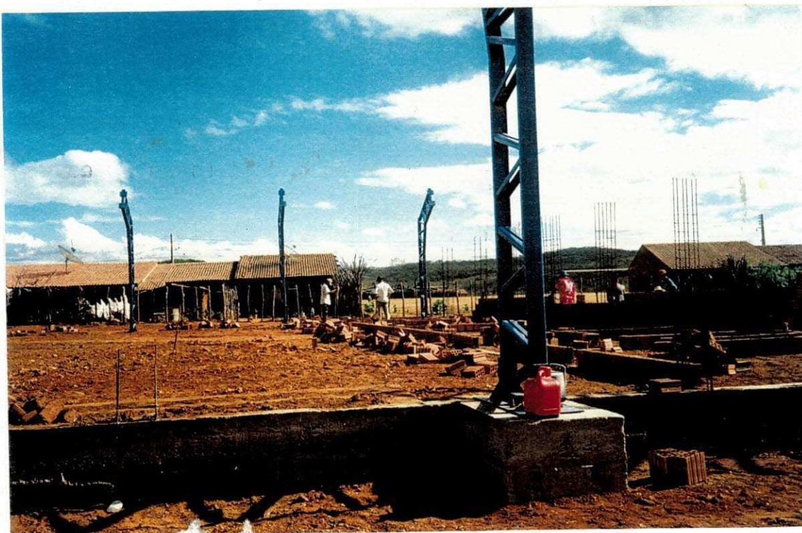
Elevação da alvenaria dos banheiros do ginásio
