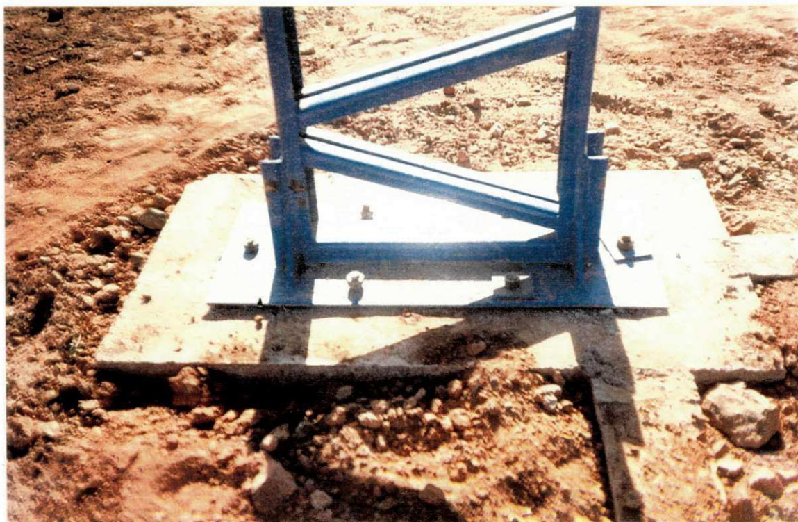
Visualização da junção pilar metálico - base através do encaixe porca - parafuso
