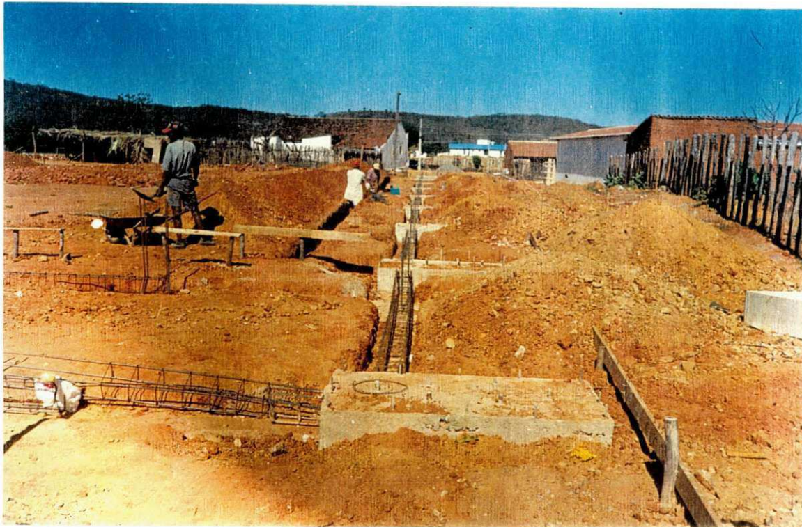
Vista da face lateral do ginásio mostrando as bases da estrutura metálica, das ferragens dos pilares laterais, da alvenaria de pedra das arquibancadas e das cintas de amarração que circunda o ginásio vista da outra face lateral
