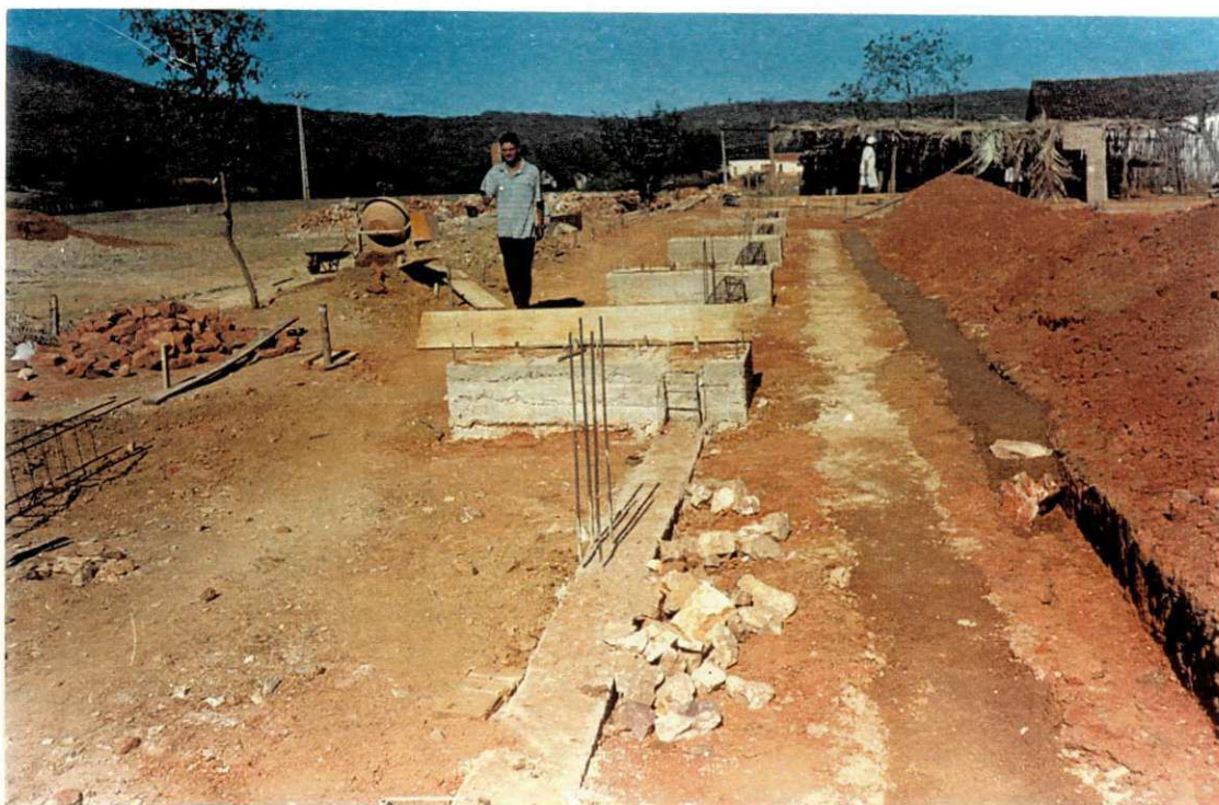
Vista da face lateral do ginásio mostrando as bases da estrutura metálica, das ferragens dos pilares laterais, da alvenaria de pedra das arquibancadas e das cintas de amarração que circunda o ginásio
