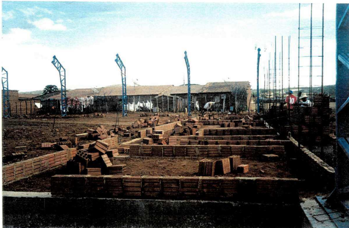
Elevação de alvenaria do palco e banheiro do ginásio Vê-se na foto acima a ferragem dos pilares da parte dos fundos do ginásio
