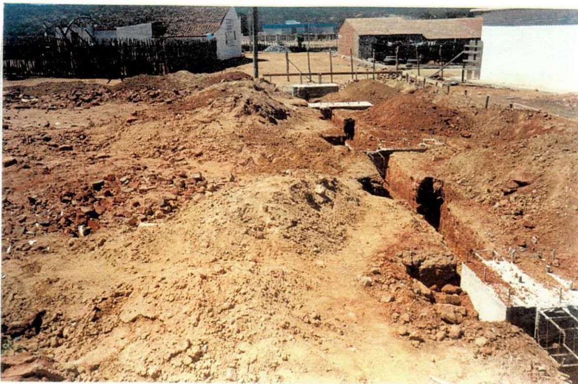
Escavação das fundações e da escavação da alvenaria de embasamento
