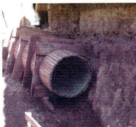
Forma do Pilar Circular
