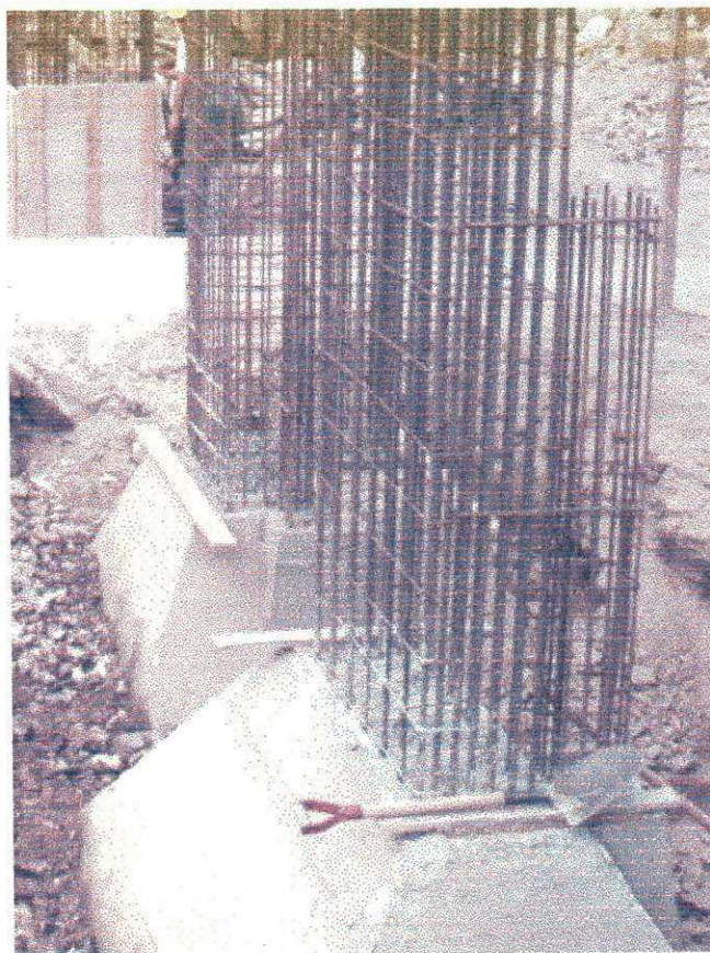
Fundações superficiais do tipo sapata
