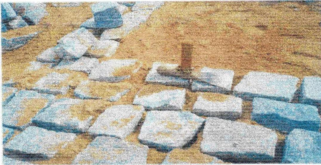
Fig.01- Assentamento dos paralelepípedos
