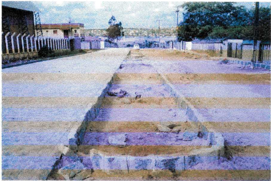
Figura 10 – Calçamento Pronto num dos Lado da Rua.
