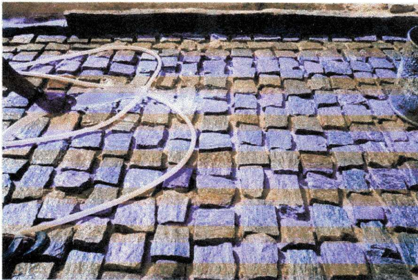
Figura 6 – Adensamento do Colchão de Areia.
