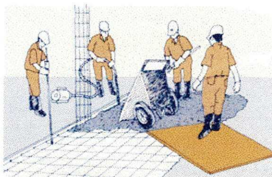
FIGURA 2.2 – Transporte de concreto através de carrinhos de mão.
