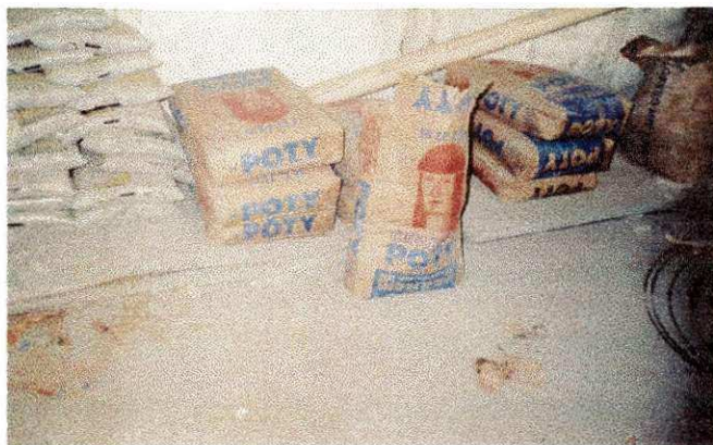
FIGURA .1- Armazenamento do cimento
