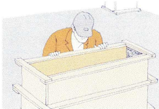
FIGURA 2.1 – Verificação das fôrmas.
