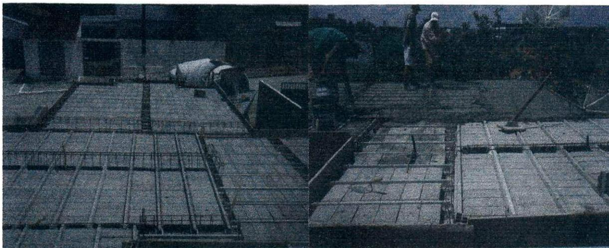
*Concretagem de uma obra com laje pré-moldada*
