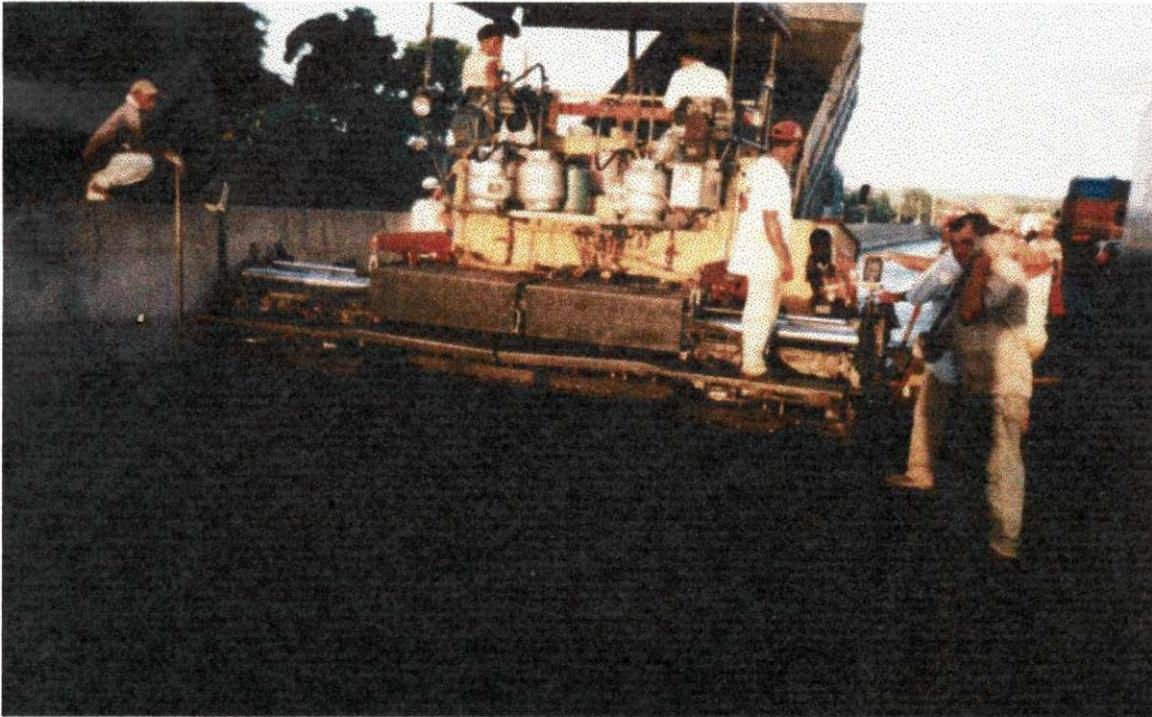
**FIGURA 7 – Máquina Acabadora/Aplicação de CBUQ**
