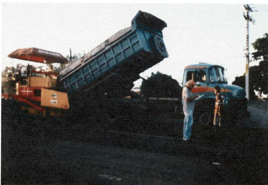
**FIGURA 10 - Depejo do CBUQ na Máquina Acabadora**
