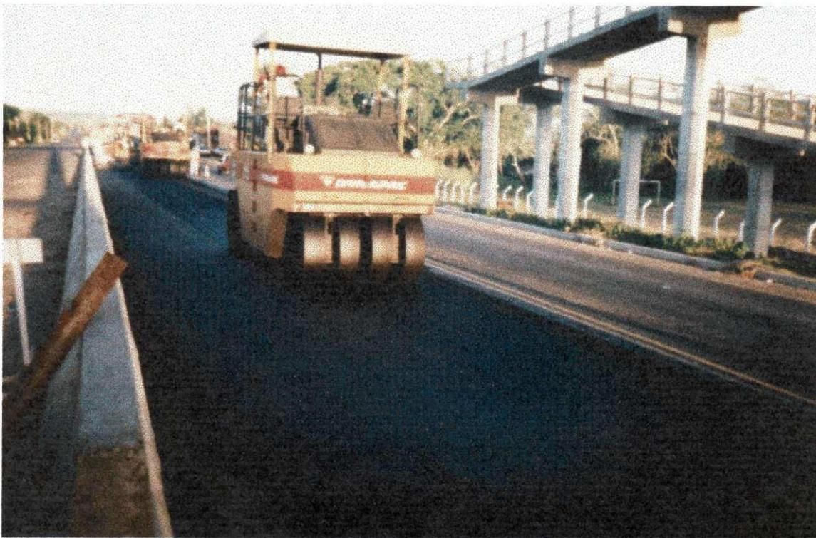
**FIGURA 8 – Rolo Pneumático/Compactação do CBUQ**
