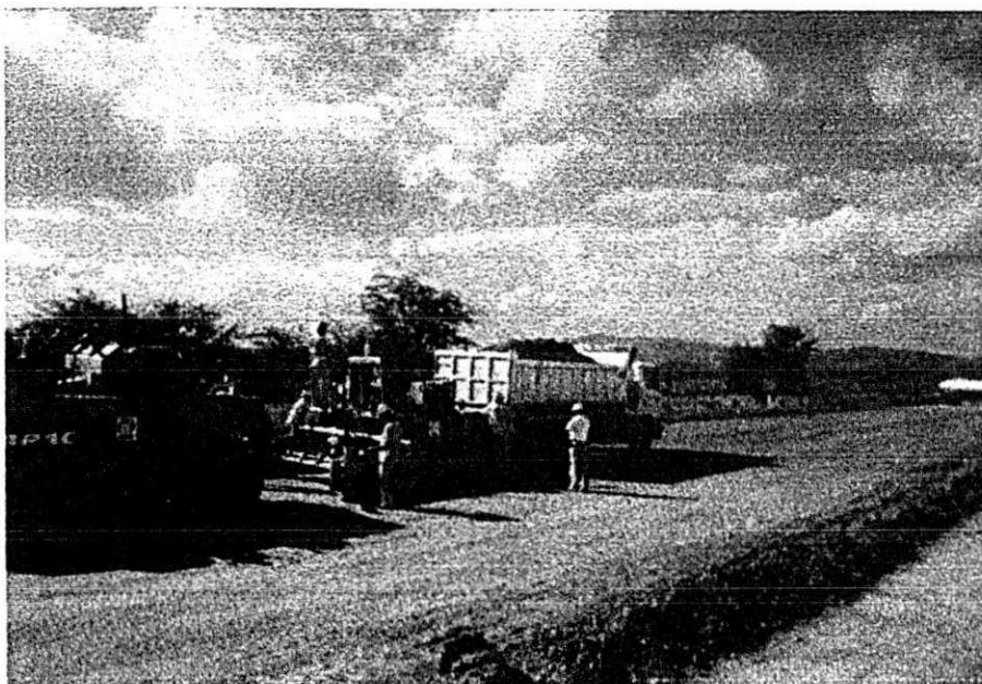
FOTO 01 - Detalhe da execução do CCR na estaca 780.
