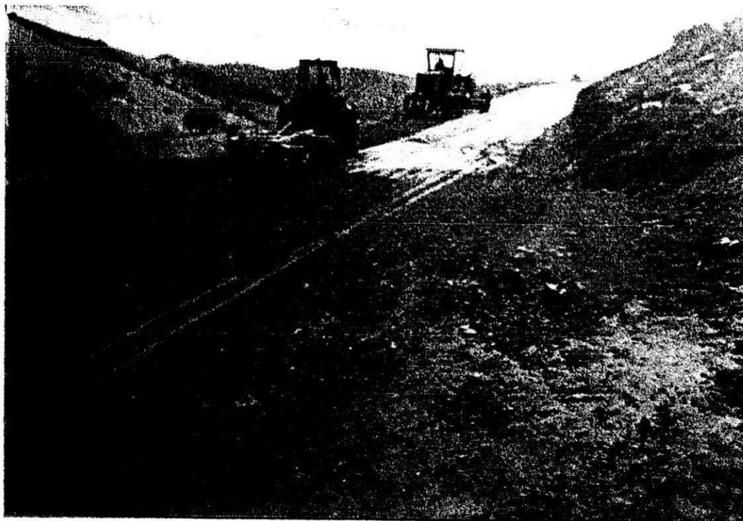
Foto 02 – Execução das camadas do pavimento
