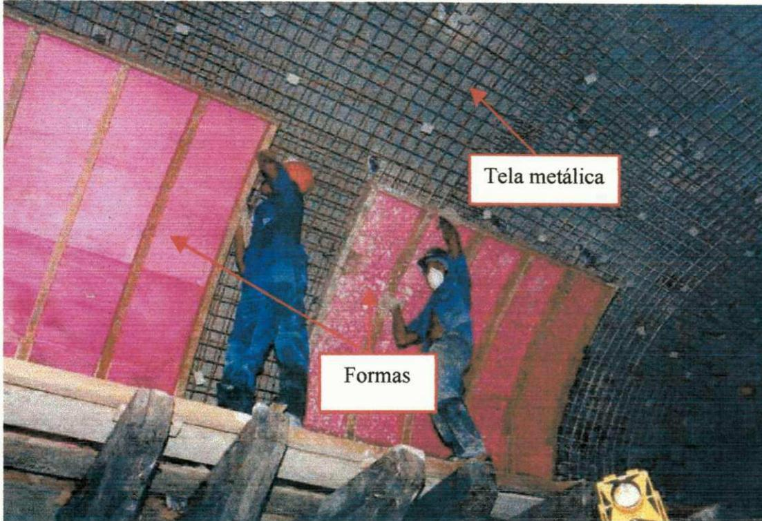
**Fig. 15** – Formas para o revestimento secundário e telas metálicas ao alto.
