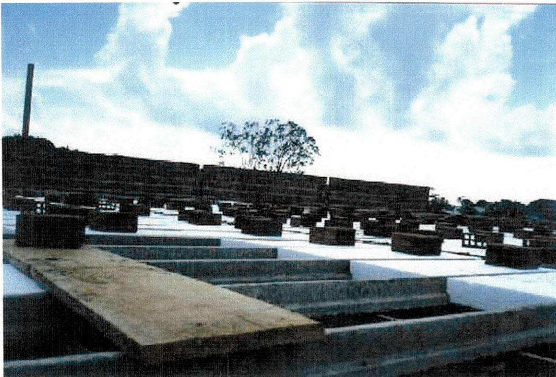
Laje pré-moldada com blocos em EPS
