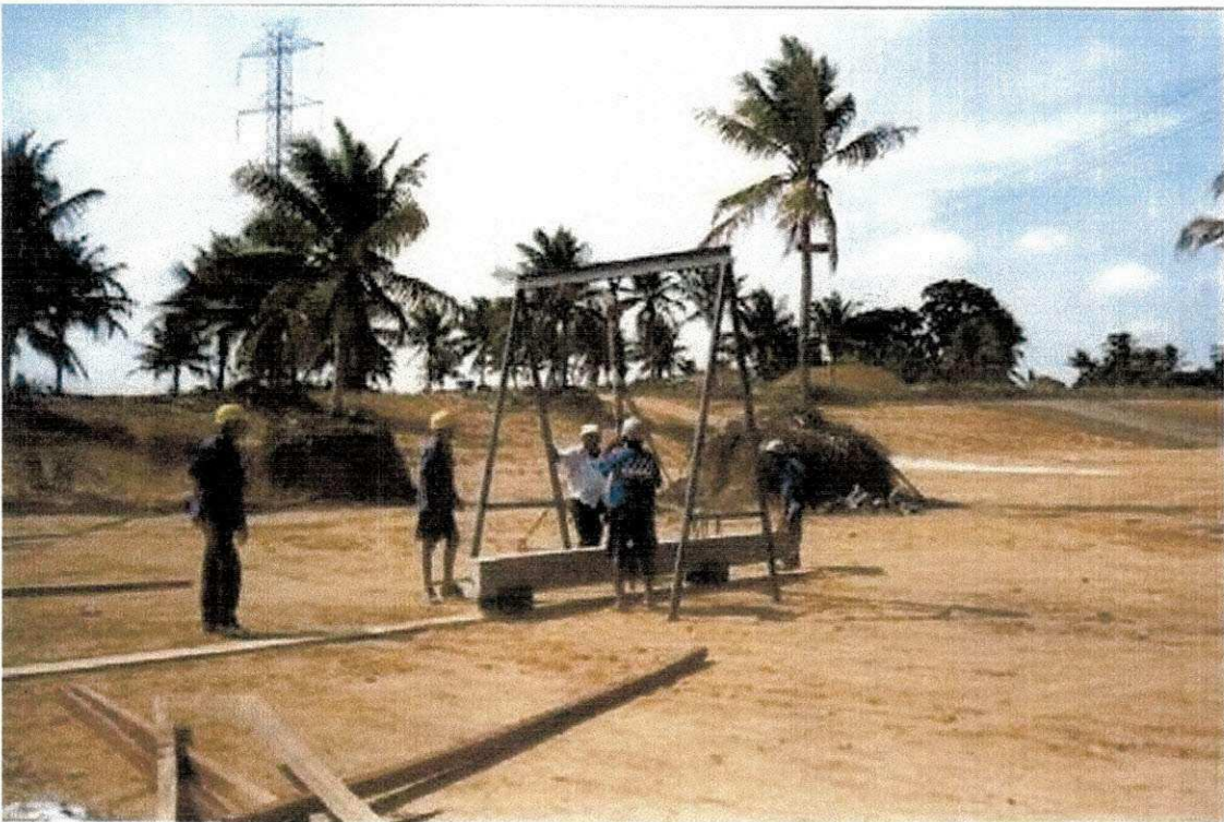
Desforma e transporte de pilar pré-moldado
