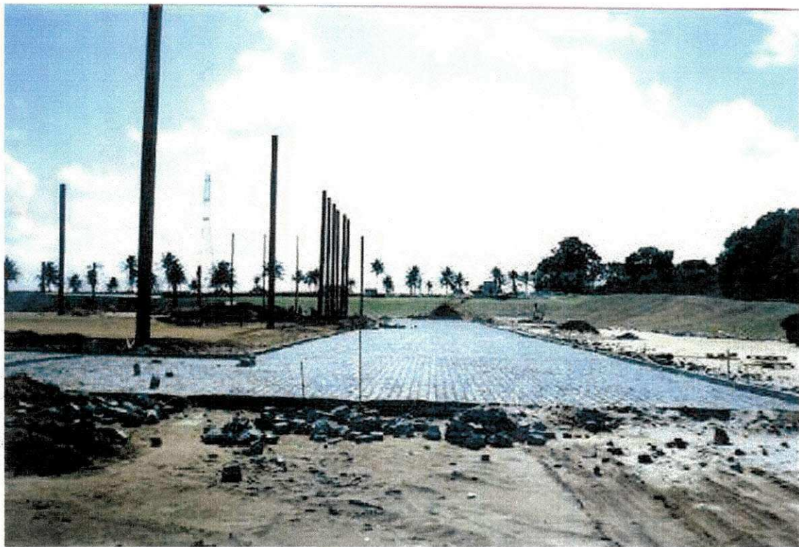
Pavimentação em paralelepípedos
