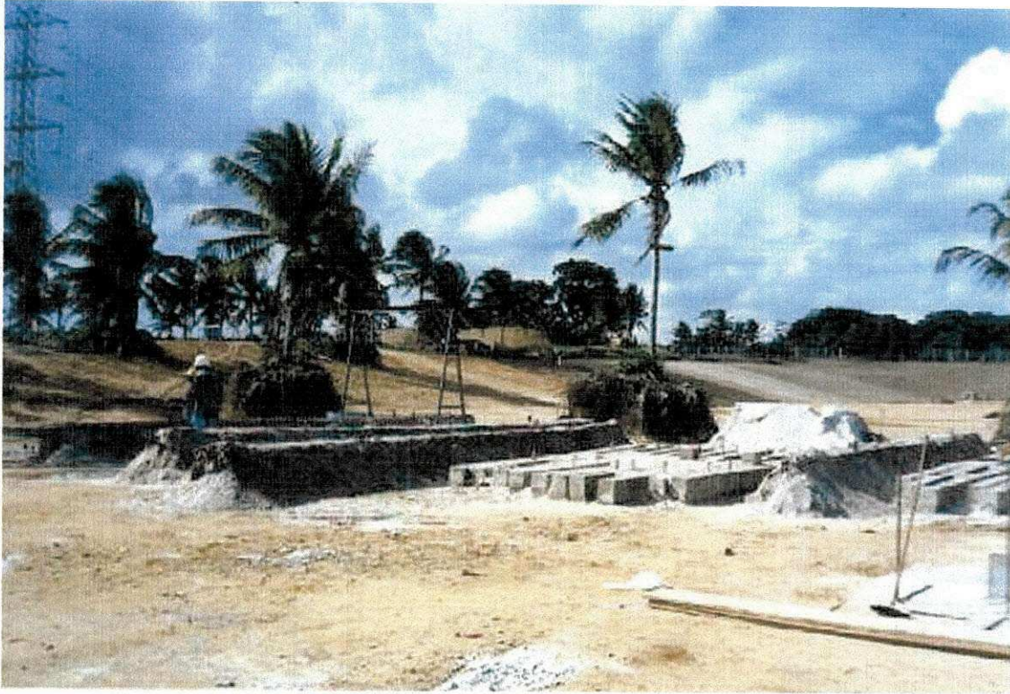
Cura úmida peças pré-moldadas
