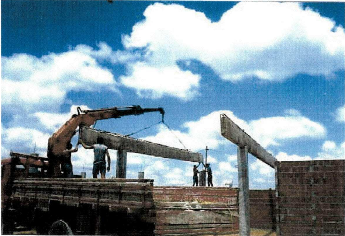
Montagem pré-moldados
