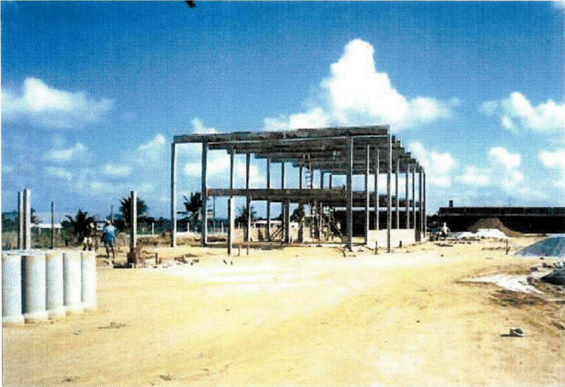
Escritório em estrutura pré-moldada
