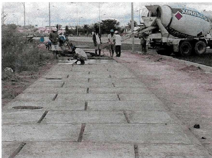
Foto 4: Calçada em Concreto Simples
