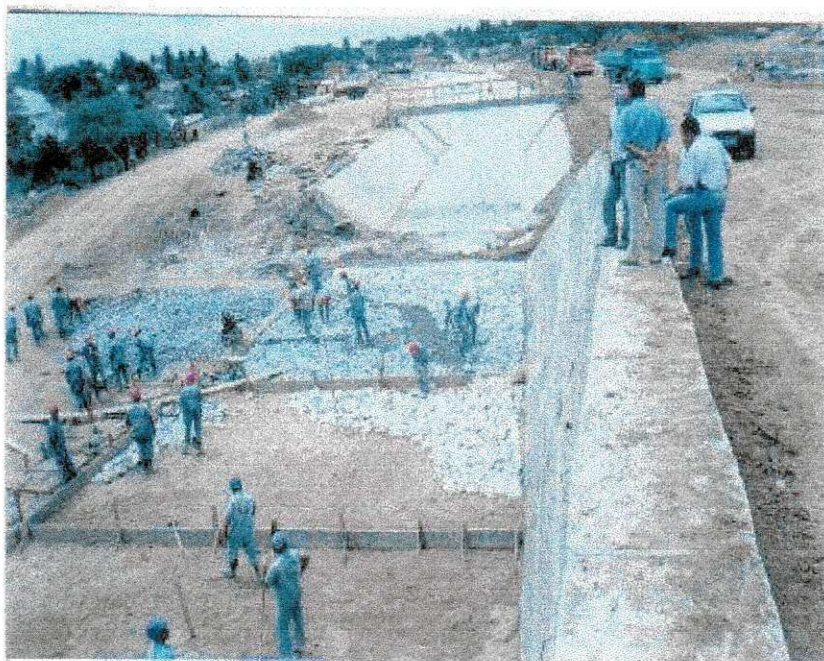
Foto 7: Canal em Concreto Ciclópico
