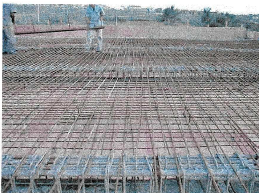
Foto 6: Ferragem da Ponte em Concreto Armado
