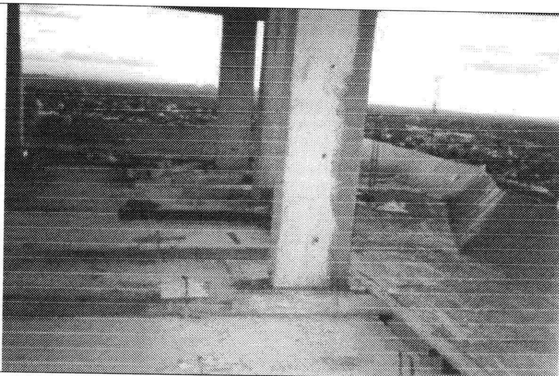
Figura 10.17.10 – “Apara-lixo” já instalado com as linhas acunhadas. A altura dos vergalhões poderia ser menor.
