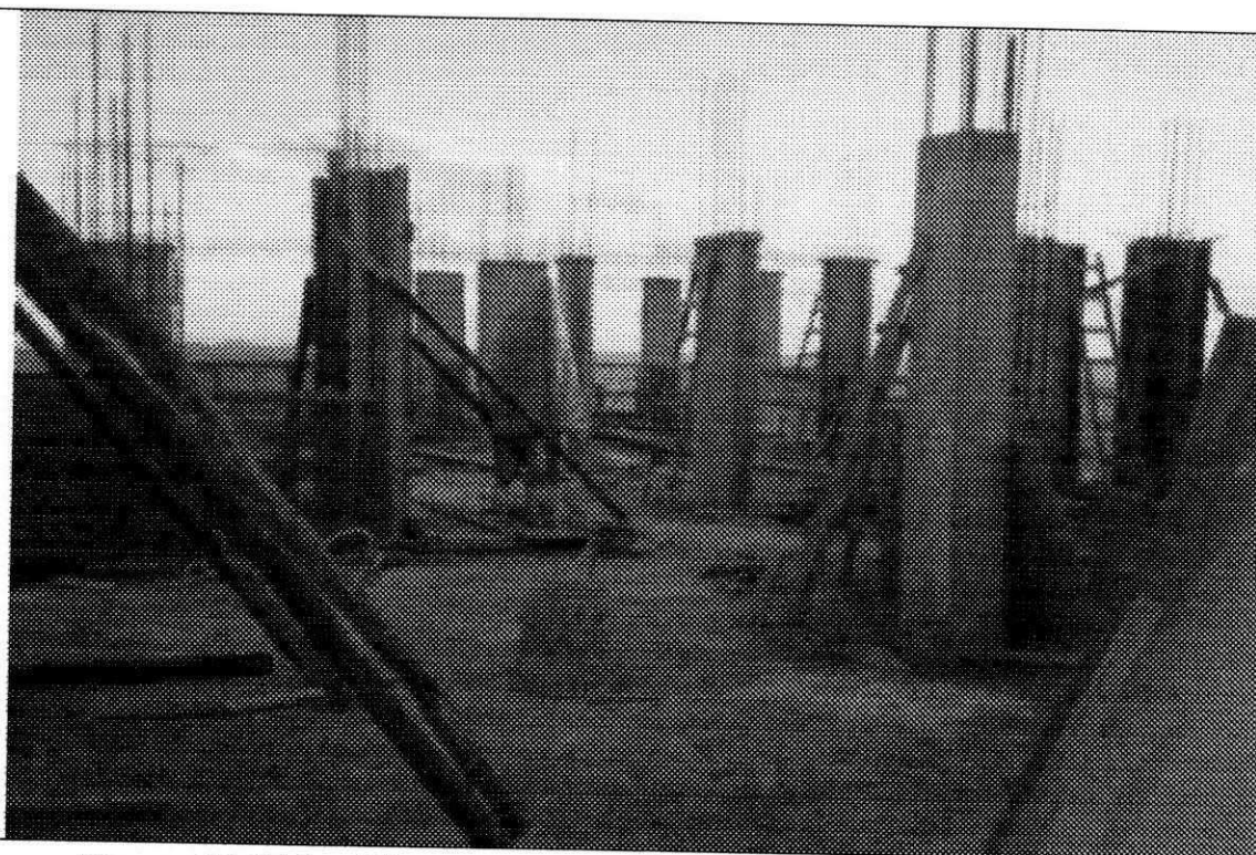
Figura 10.17.6 – Pilares nas suas mais variadas fases de elaboração
