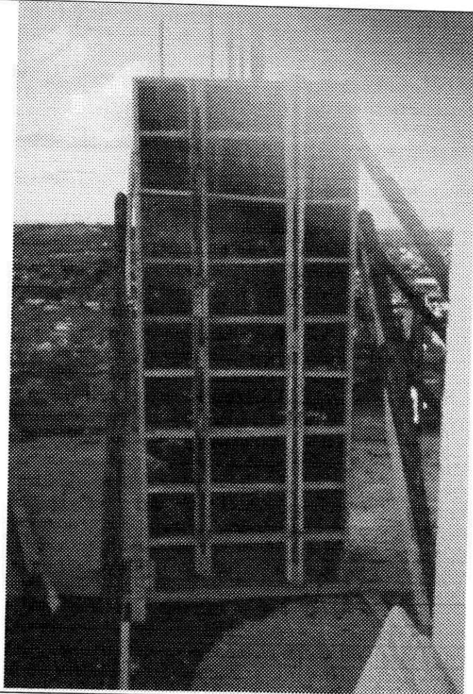
Figura 10.17.7 – Pilar “P A ” (20 cm x 90cm) com sua fôrma e escoramento
