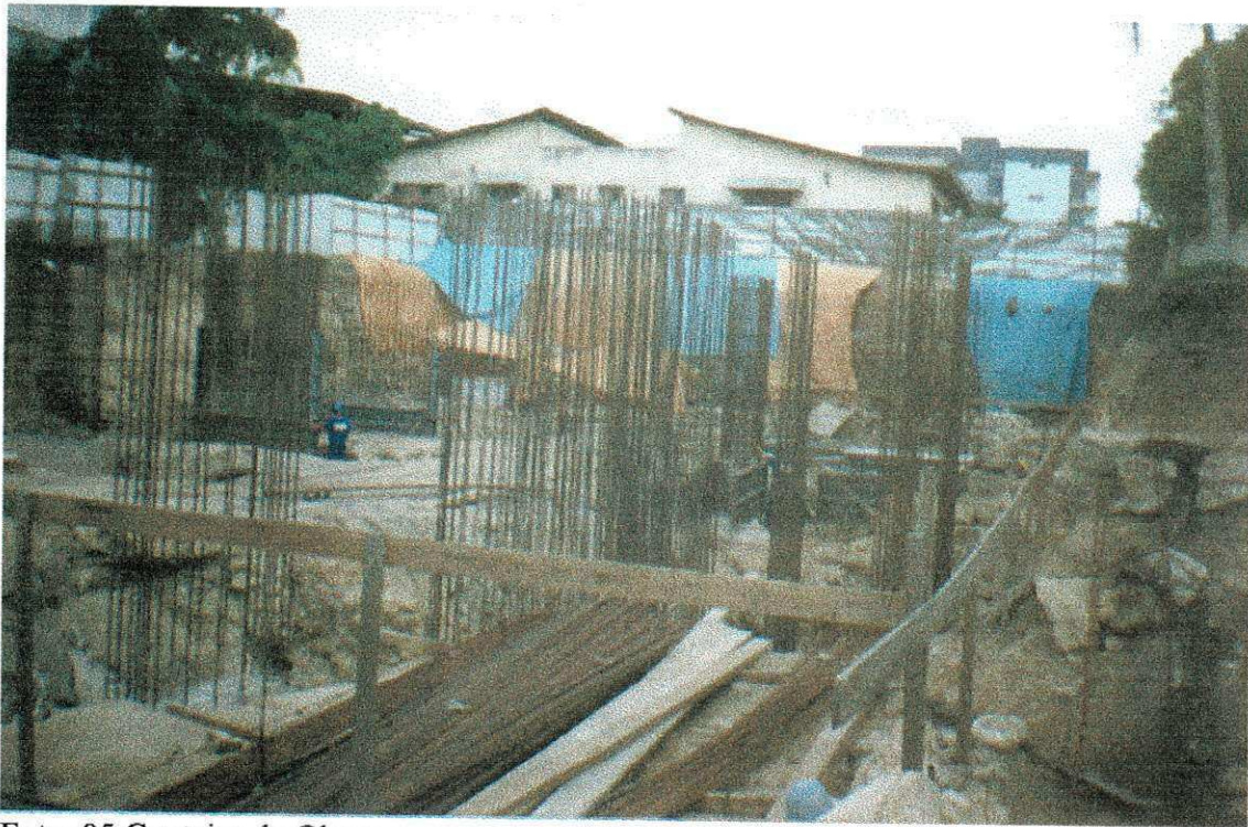
Foto: 05 Canteiro de Obras
