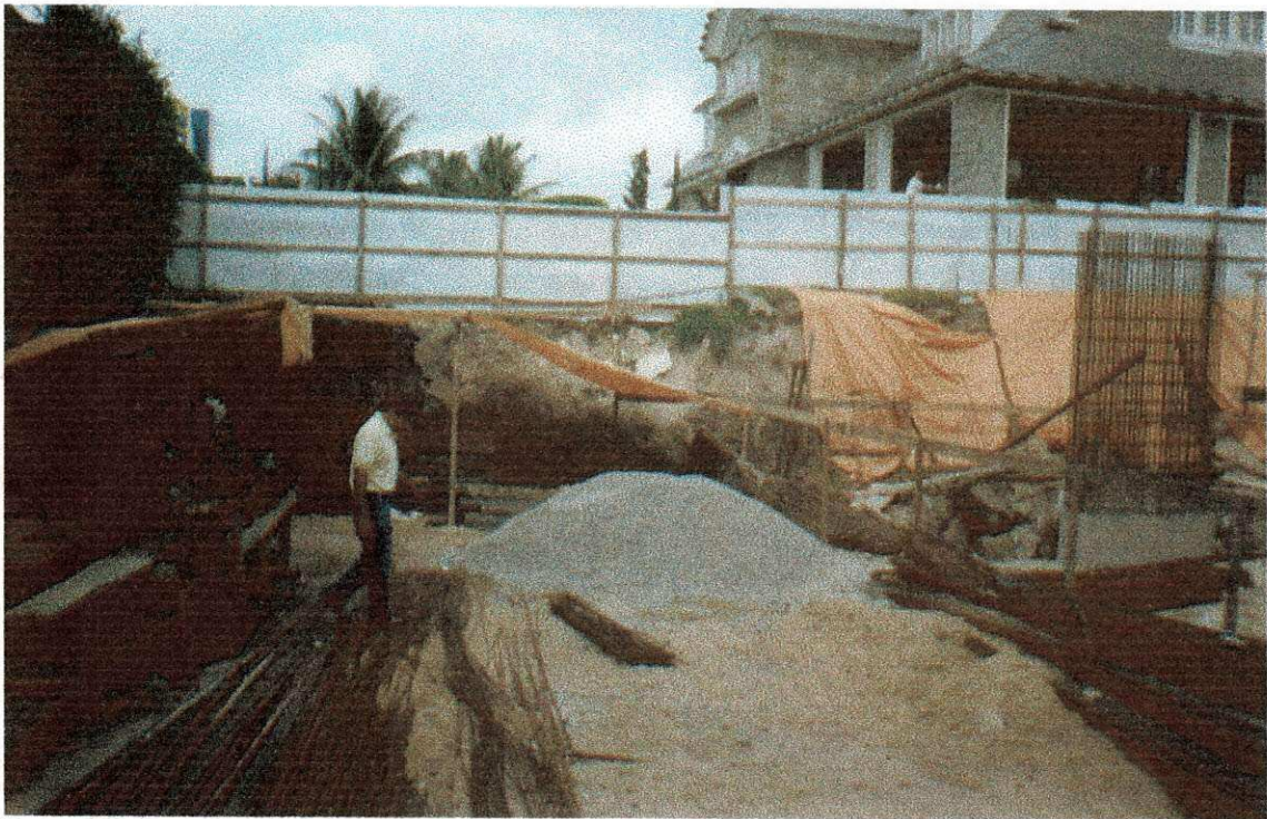
Foto: 08 Canteiro de Obras
