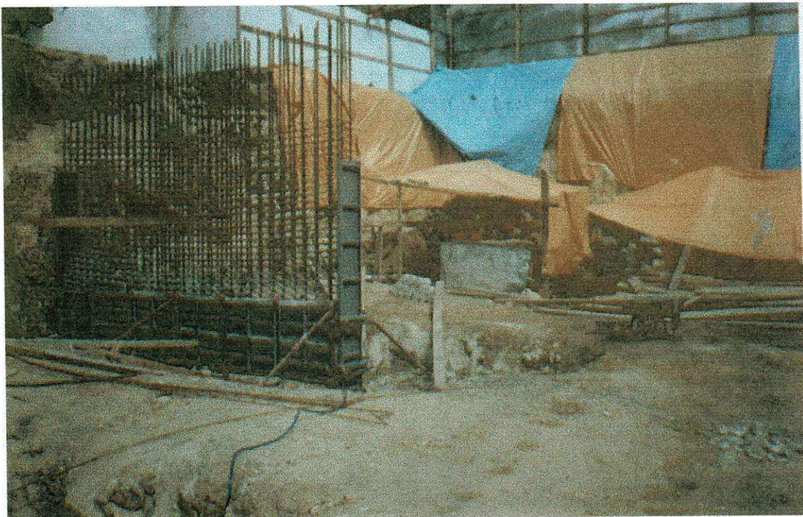
Foto: 04 Arranque de pilar
