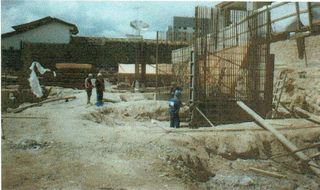
Foto 01: Arranque de Pilar
