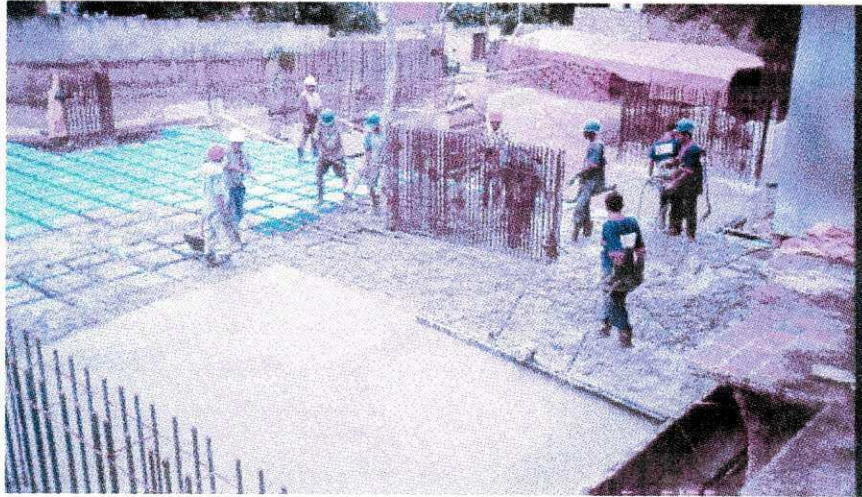
Figura 3 - Concretagem da laje
