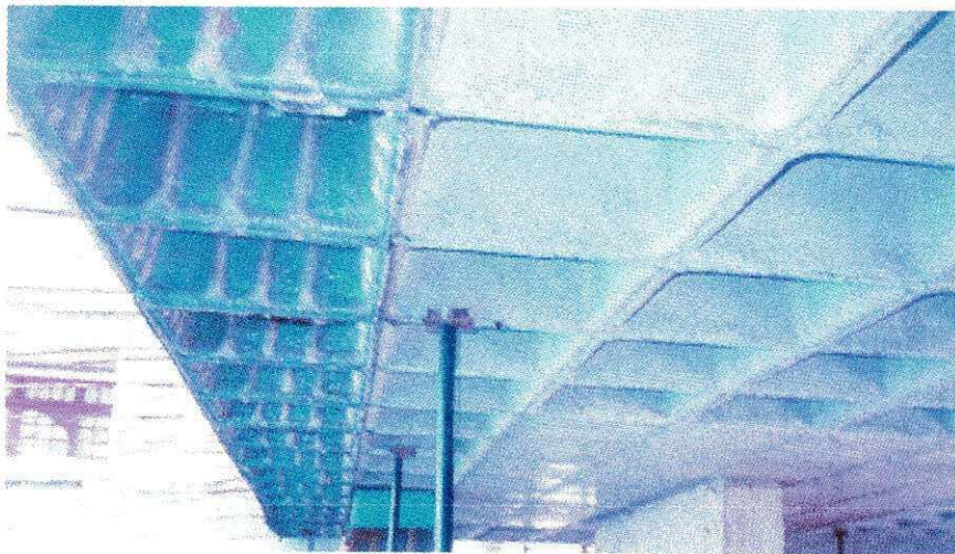
Figura 6 – Laje após retiradas das cumbucas e ferragem de espera ( à esquerda)
