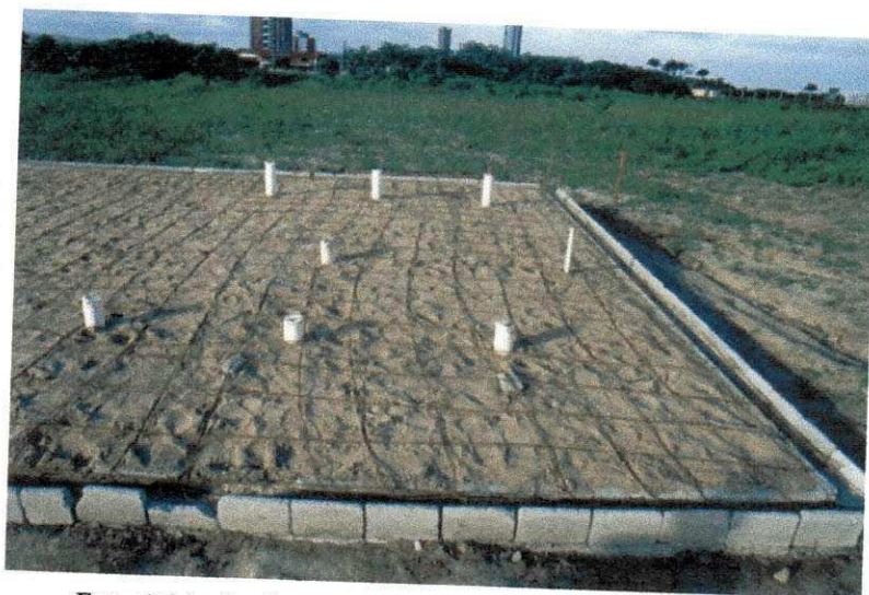
Foto: 2 (a) – Radier com a tubulação de esgoto e a armadura.
