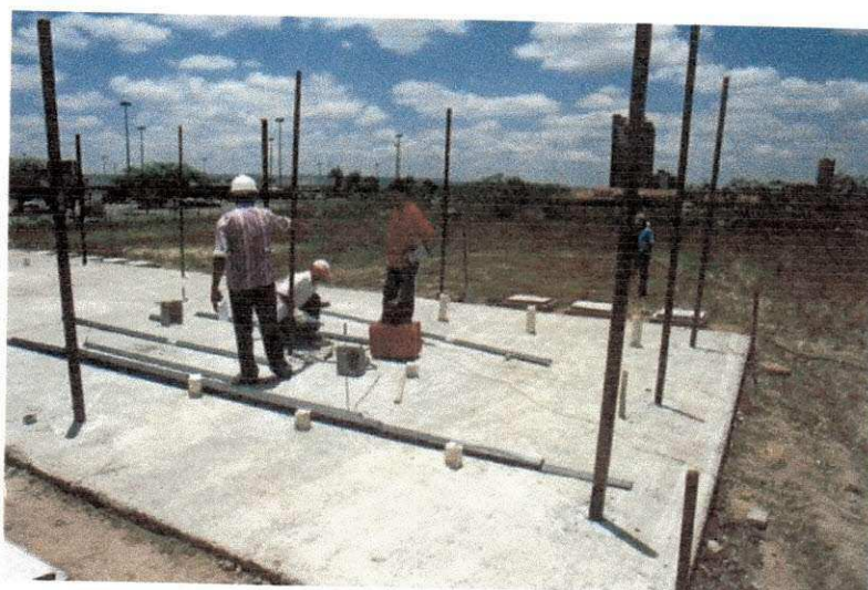
Foto: 6 (b) – Armação da estrutura metálica.
