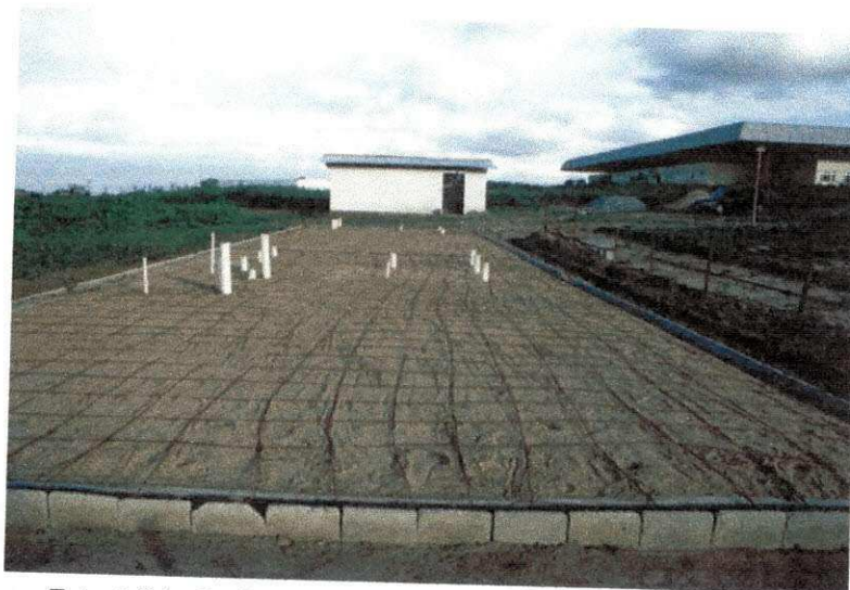
Foto: 2 (b) – Radier com a tubulação de esgoto e a armadura.
