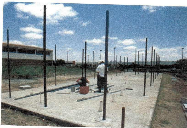
Foto: 6 (a) – Armação da estrutura metálica.
