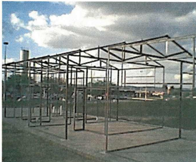
Foto: 7 (a) – Estrutura metálica parcialmente pronta.
