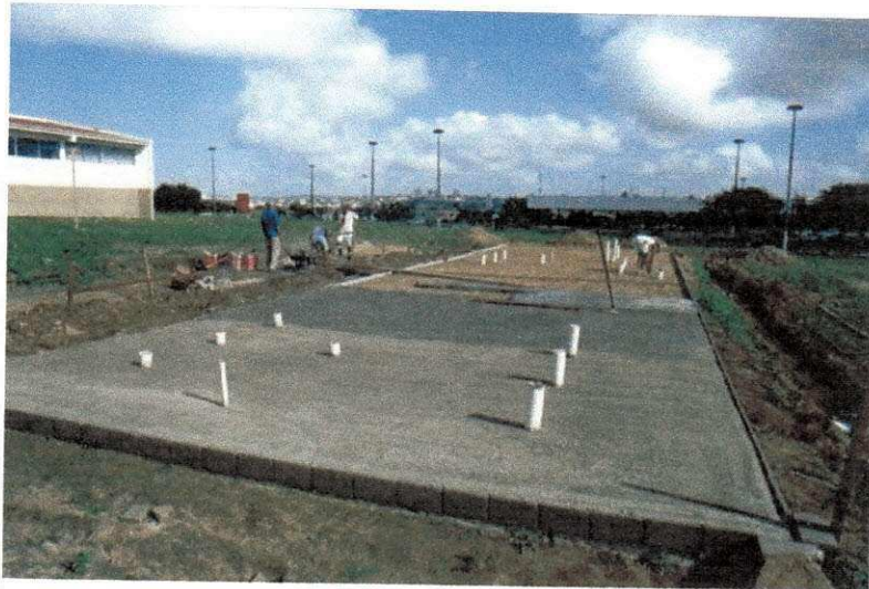
Foto: 3 (b) – Concretagem do radier.
