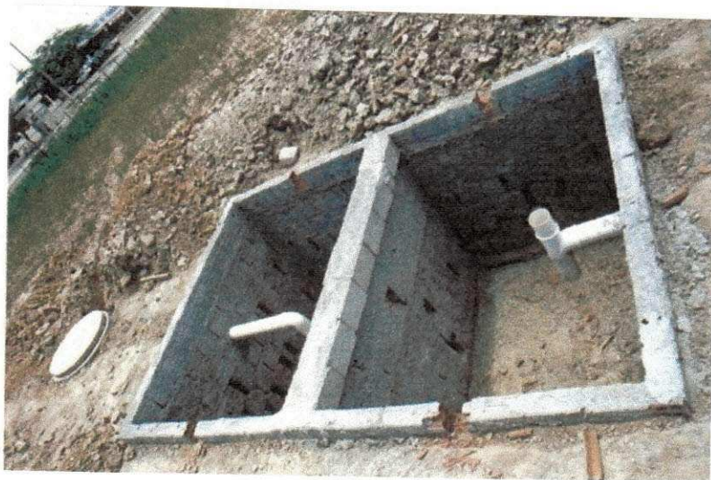
Foto: 5 (a) – Tanque séptico dos BWC's.
