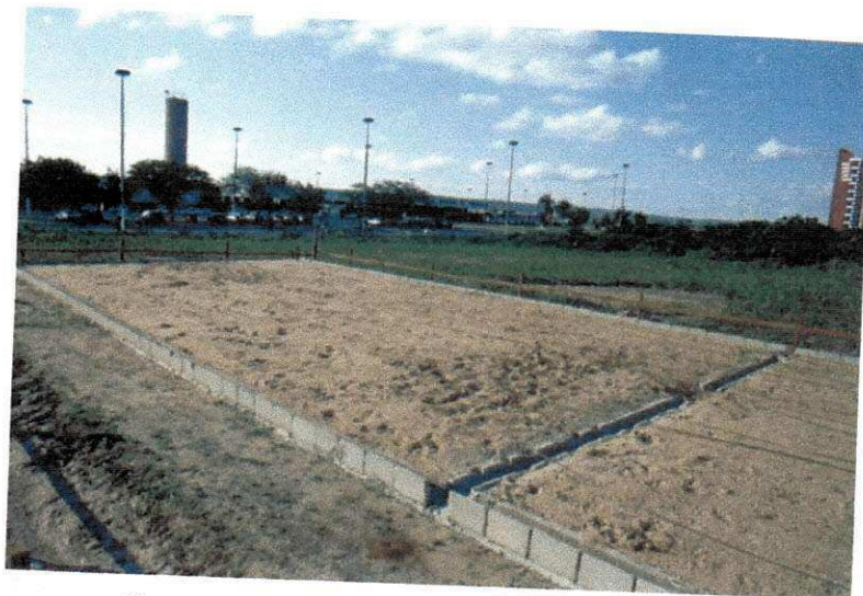
Foto: 1 – Radier com a base preenchida com areia
