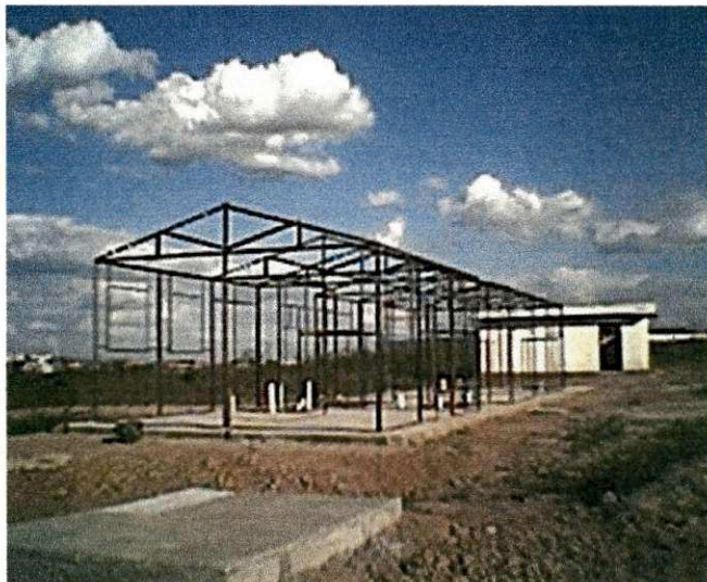
Foto: 7 (c) – Estrutura metálica parcialmente pronta.
