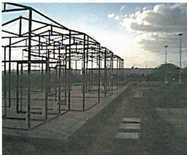
Foto: 7 (b) – Estrutura metálica parcialmente pronta.
