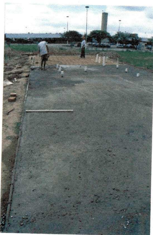
Foto: 3 (a) – Concretagem do radier.
