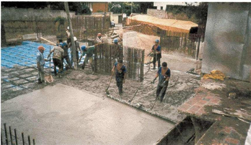
**Figura 2 - Concretagem da laje**
