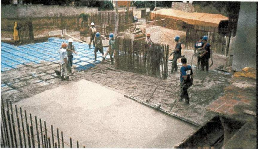
**Figura 3 - Concretagem da laje**
