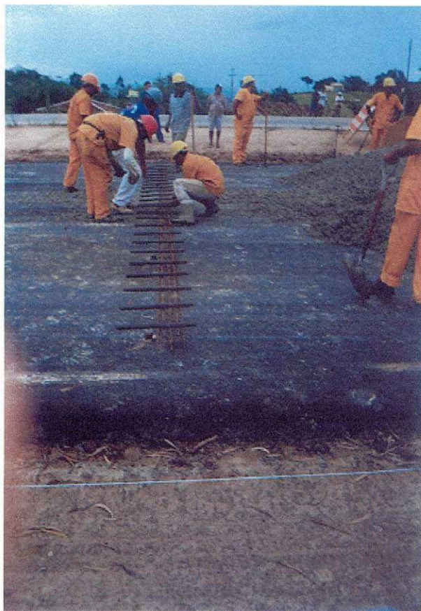
Figura 10: Colocação das barras de transferência na pista de duplicação.
