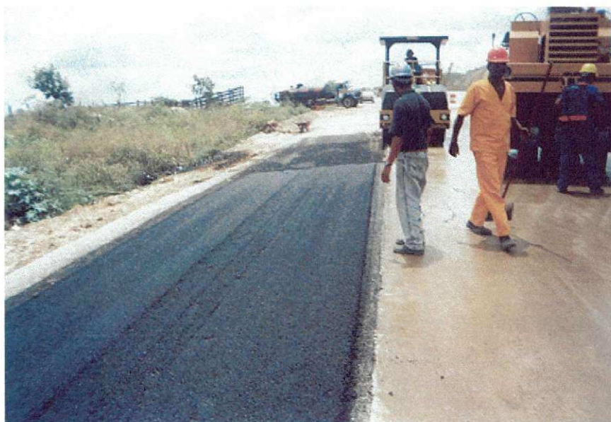
Figura 1: Execução de acostamento na pista de duplicação.
