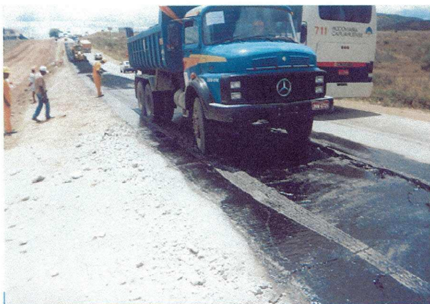
Figura 6: Aplicação da camada de ligação na pista de recuperação.
