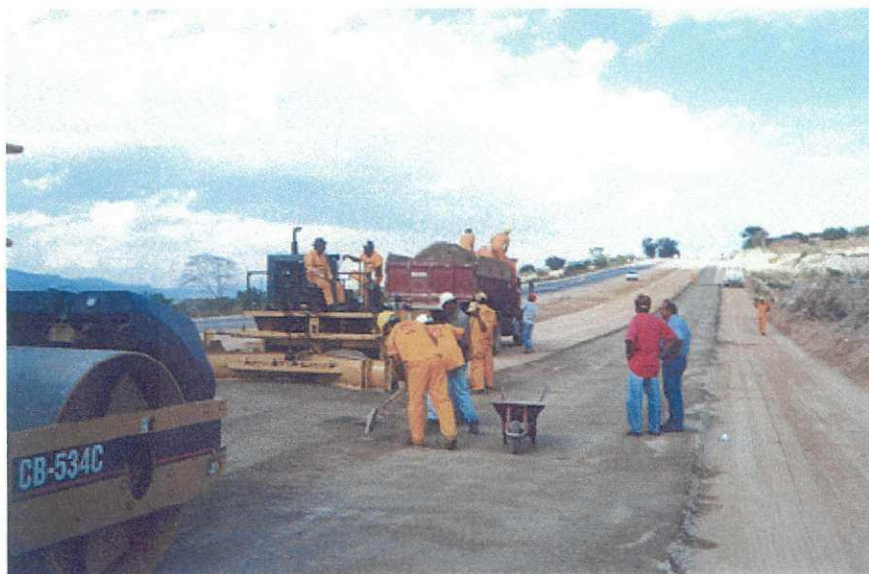
Figura 2: Alargamento do acostamento para execução de parada de ônibus.
