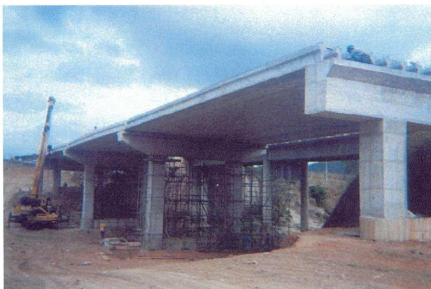
Figura 3: Execução de ponte na pista de duplicação.
