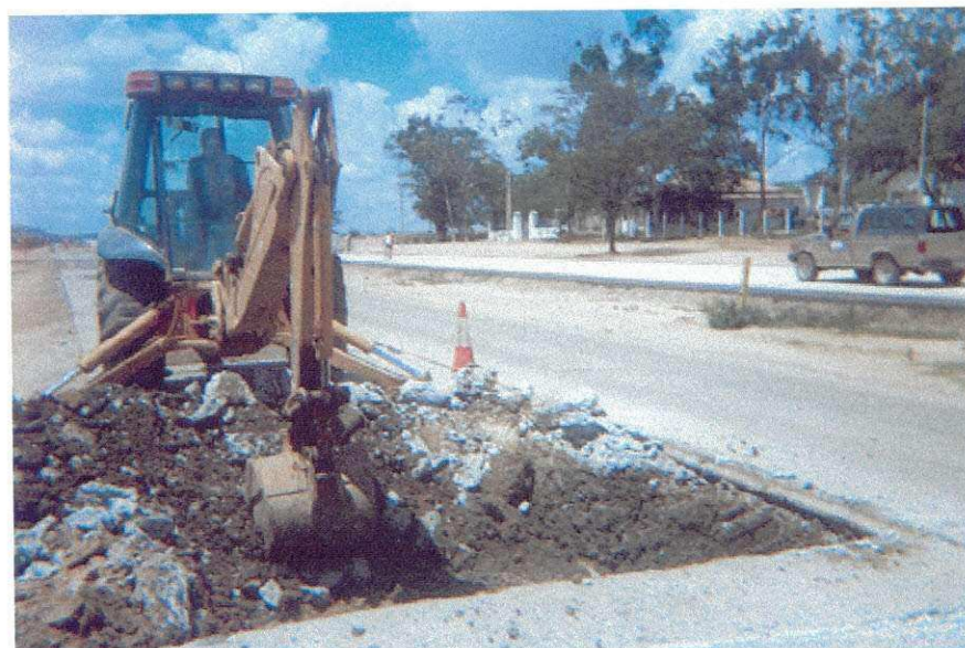
Figura 9: Remoção de placa de concreto após o craqueamento.
