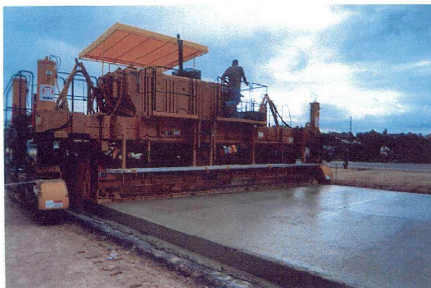
Figura 7: Máquina Pavimentadora em execução.
