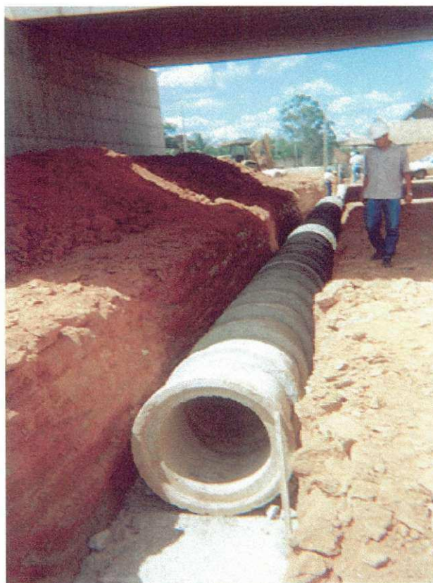
Figura 5: Drenagem sob viaduto de Gravatá.
