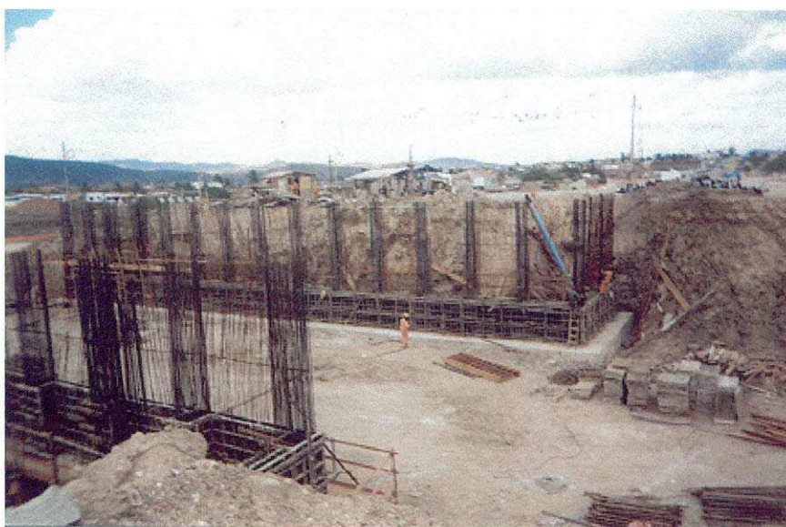
Figura 11: Armação e concretagem do viaduto.
