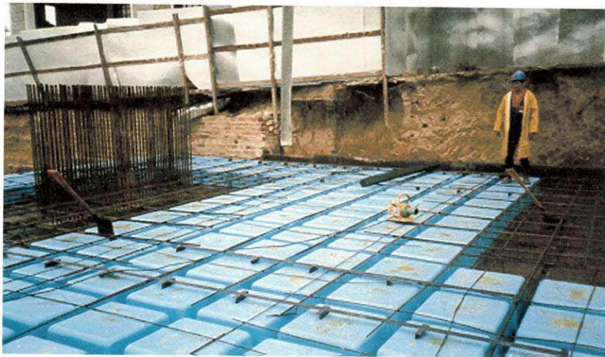
Figura 1 - Laje pronta para concretagem e com o nivelador de cobertura
