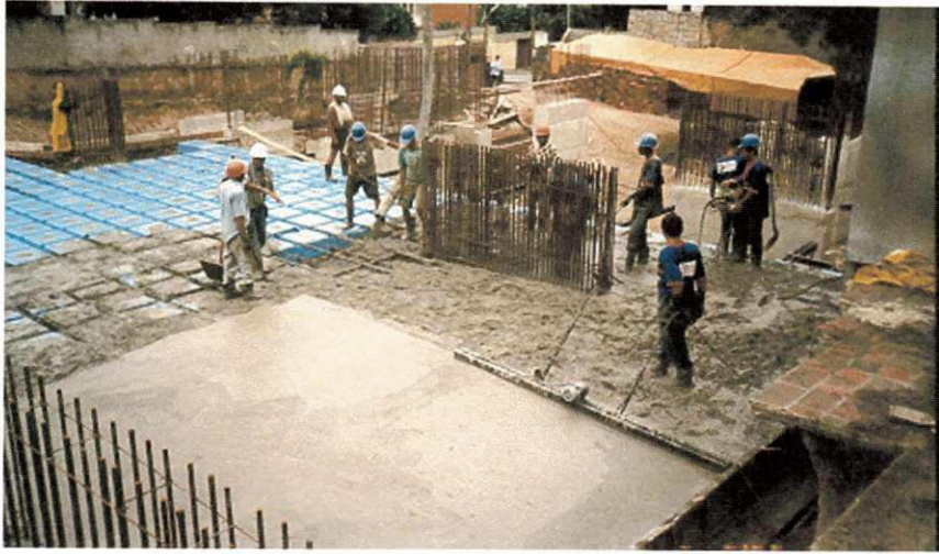
Figura 3 - Concretagem da laje
