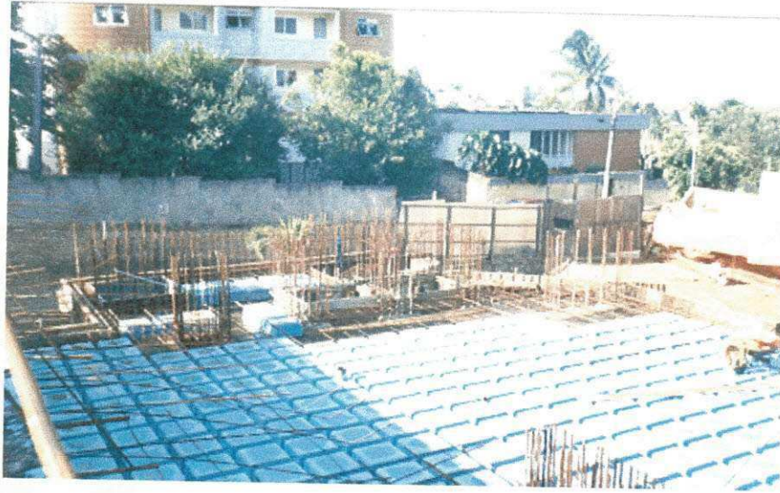
Figura 7 - Laje a pronta para concretagem
