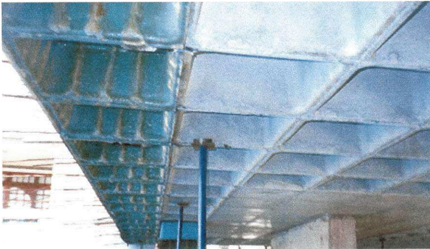
Figura 6 - Laje após retiradas das cumbucas
