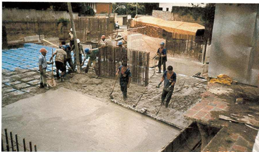
Figura 2 - Concretagem da laje
