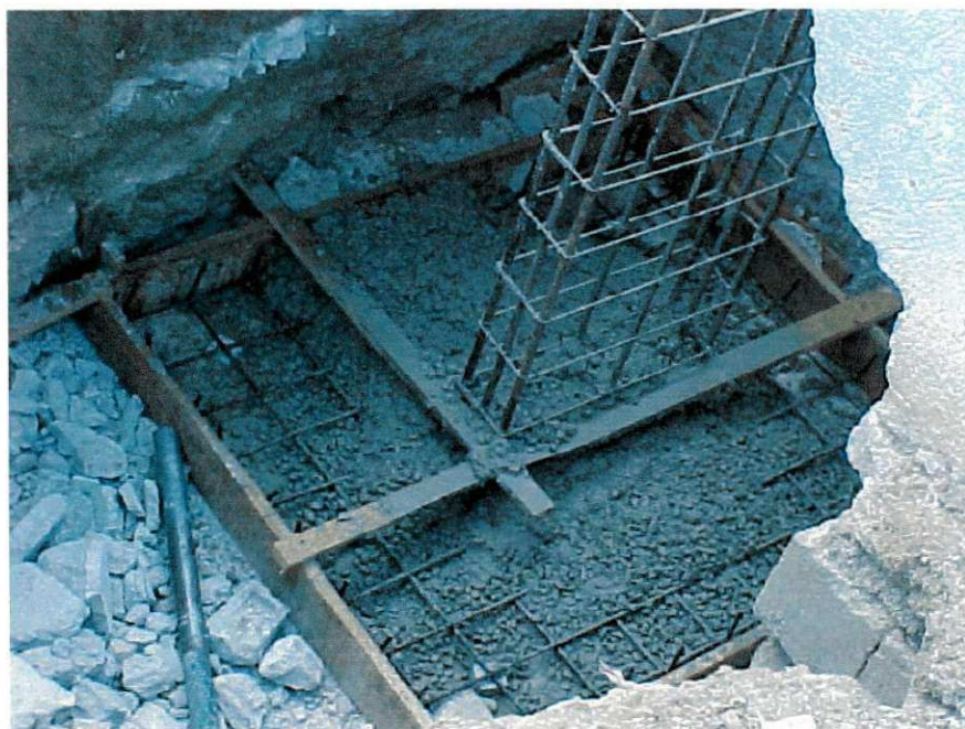
Concretagem de Peça Estrutural
