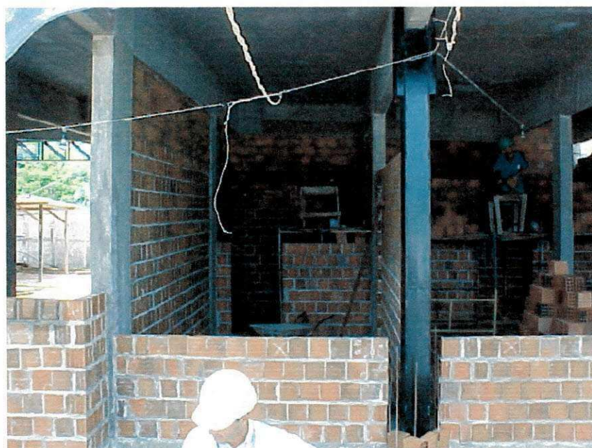
Alvenaria de Vedação
