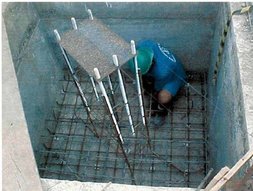
Montagem de Armadura
