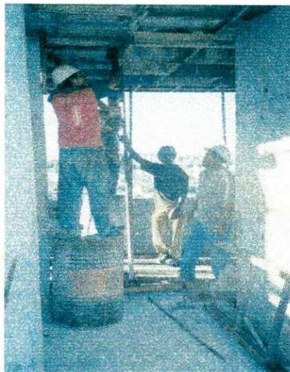
Figura 5. Retirada das Formas
