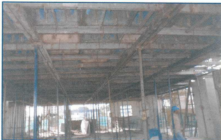
Figura 11 – Pontaletes metálicos.
