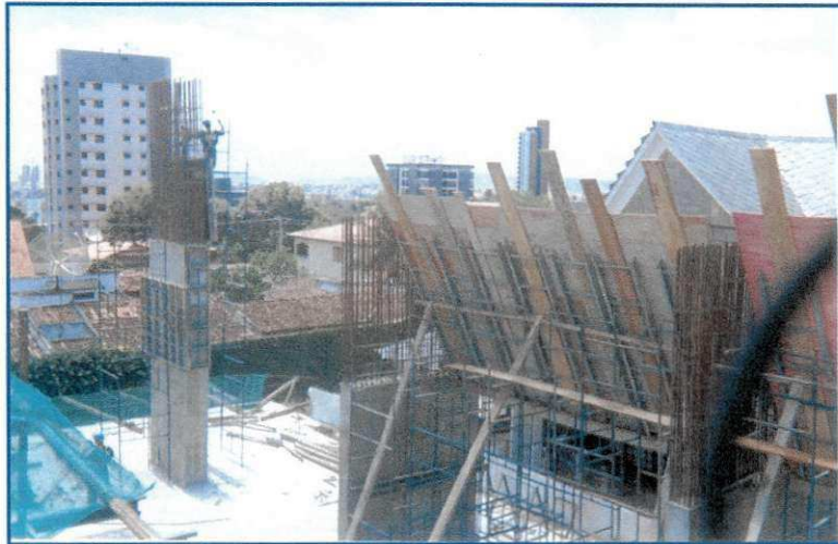
Figura 15 – Escoramento da viga inclinada.
