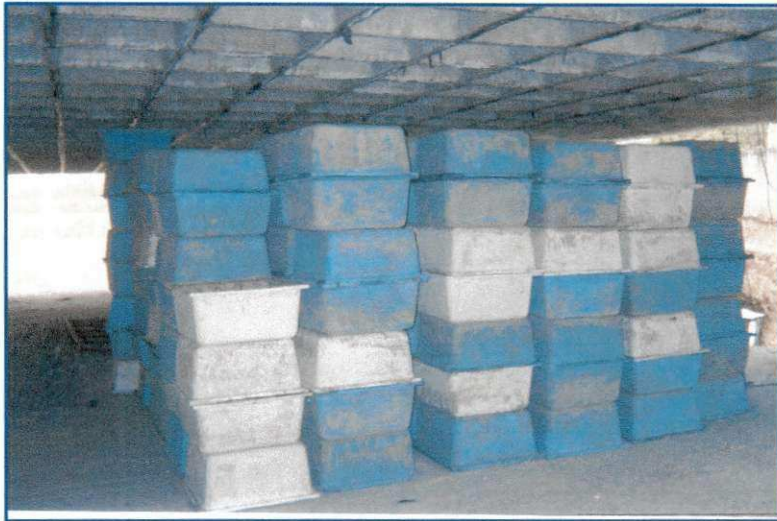
Figura 6 – Cumbucas utilizadas na laje.
