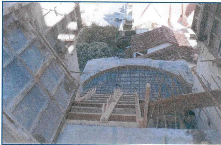
Figura 10 – Detalhe das ferragens da escada.
