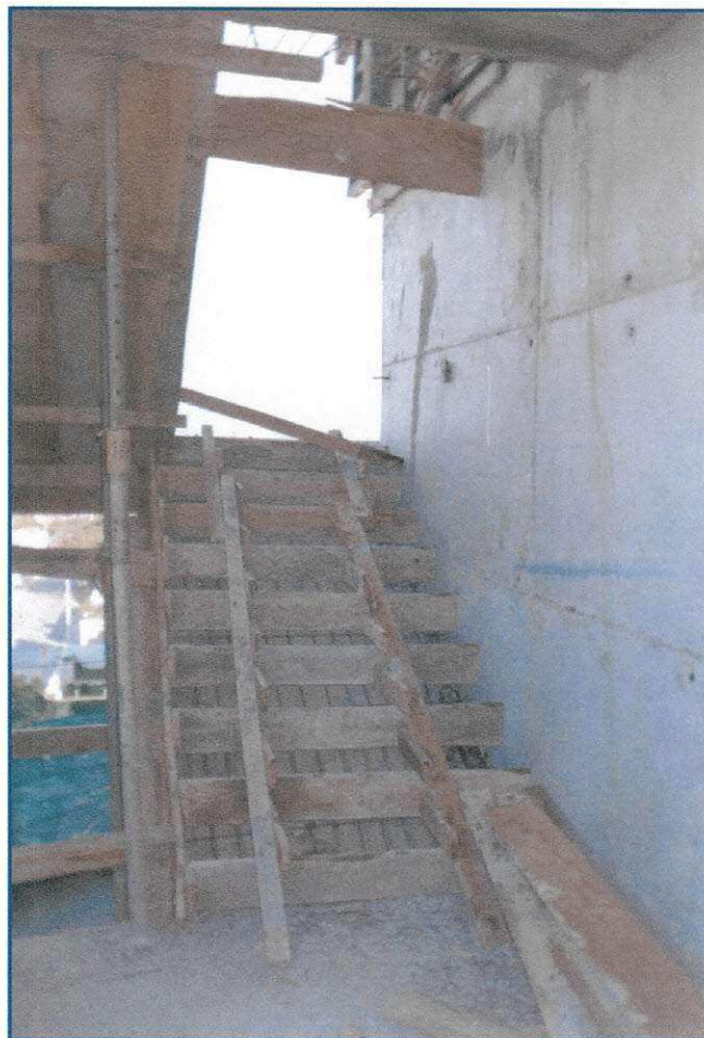
Figura 19 – Fôrma da escada.
