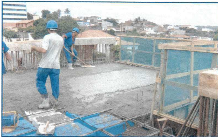
Figura 18 – Concretagem da laje.
