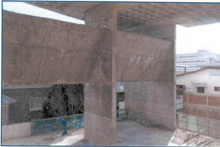
Figura 9 – Detalhe da viga inclinada colocada para contraventar os pilares.
