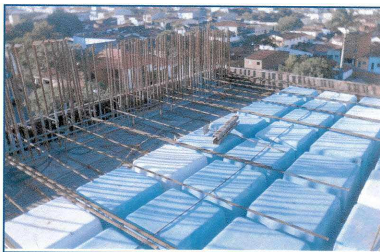
Figura 13 – Detalhe das armaduras do pilar e da laje.
