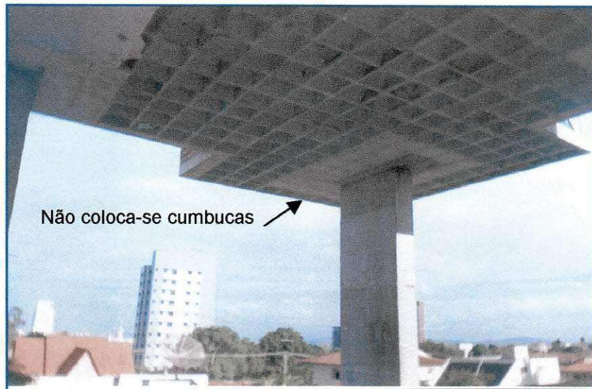
Figura 4 – Detalhe da laje ao redor do pilar.
