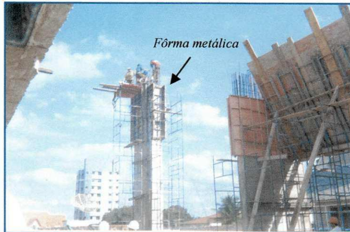
Figura 5 – Fôrma metálica utilizada no pilar.
