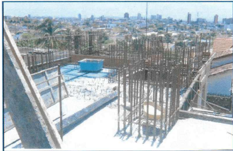
Figura 16 – Ferragem de espera.
