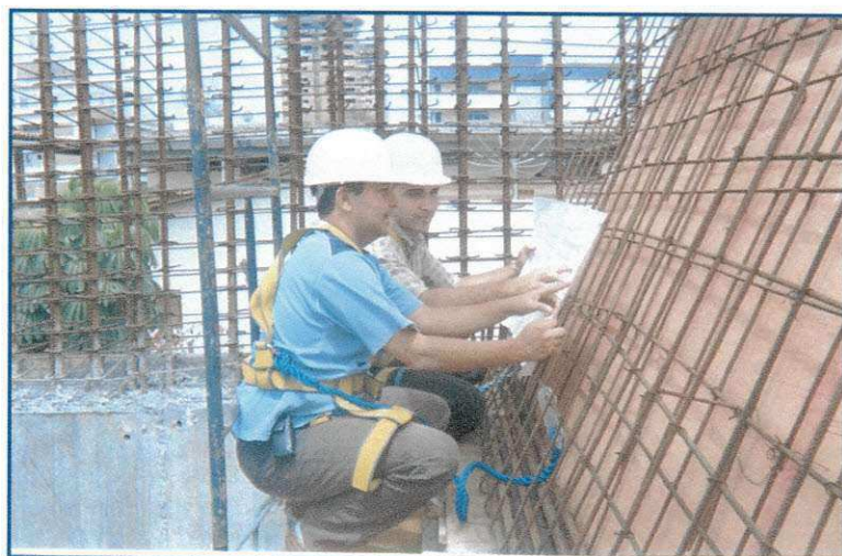
Figura 14 – Verificação das ferragens da viga inclinada.
