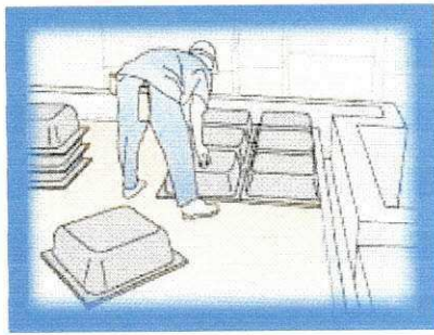
Figura 2 – Colocação das Formas
