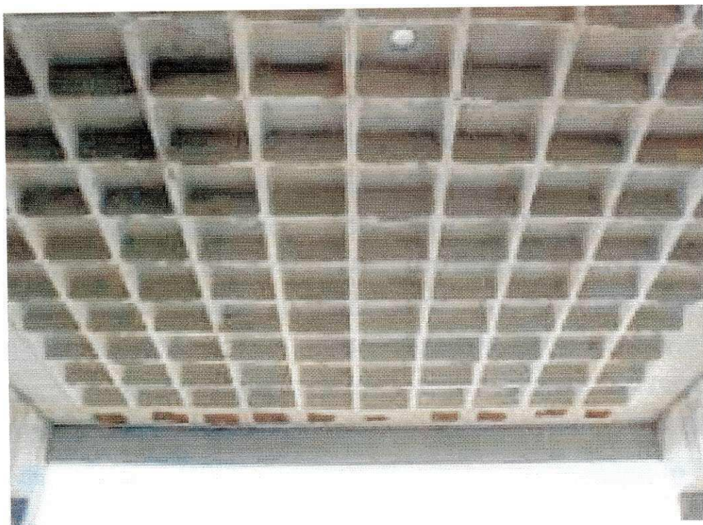
Foto 3 – Vista inferior das nervuras da laje.
