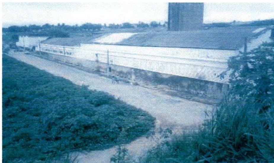
Figura 4.1 - Vista geral das instalações da IPELSA – Campina Grande (PB).
