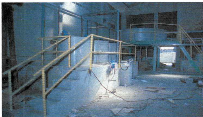
Figura 5.14 – Escada de acesso aos tanques de misturas químicas.
