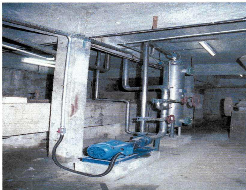
Figura 5.6 – Tubo dissolvedor de ar.
