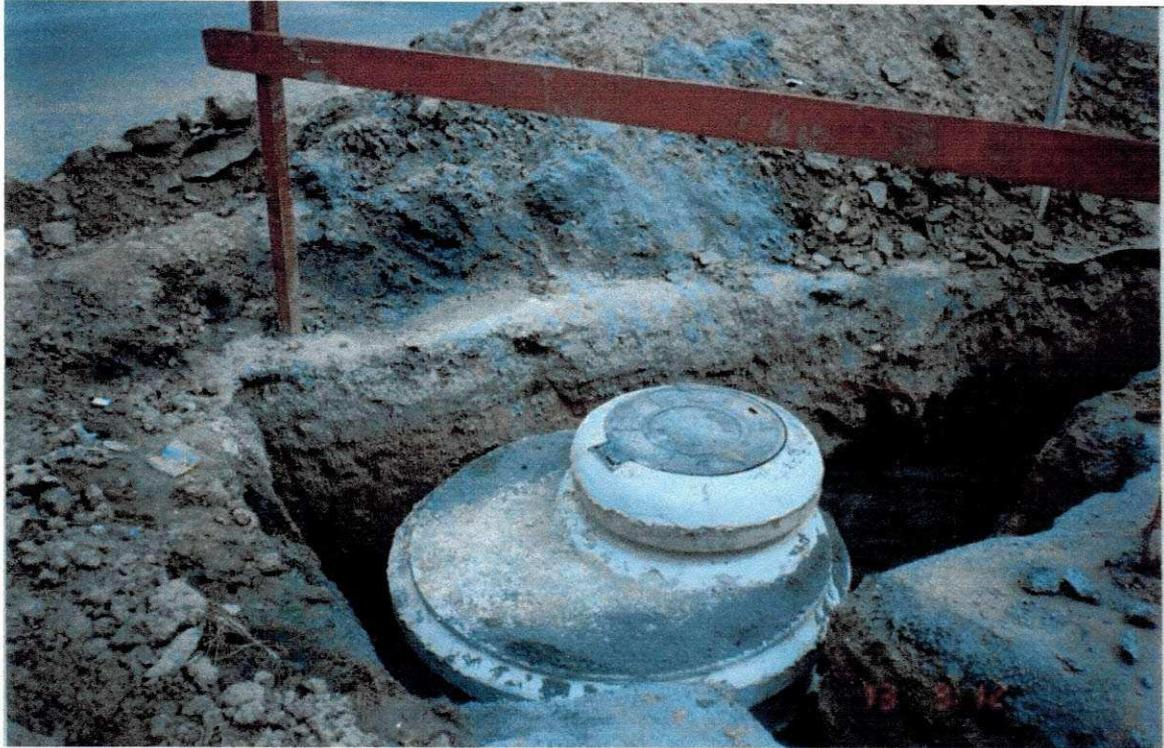
**POÇO DE VISITA EM ANÉIS PREMOLDADOS**
