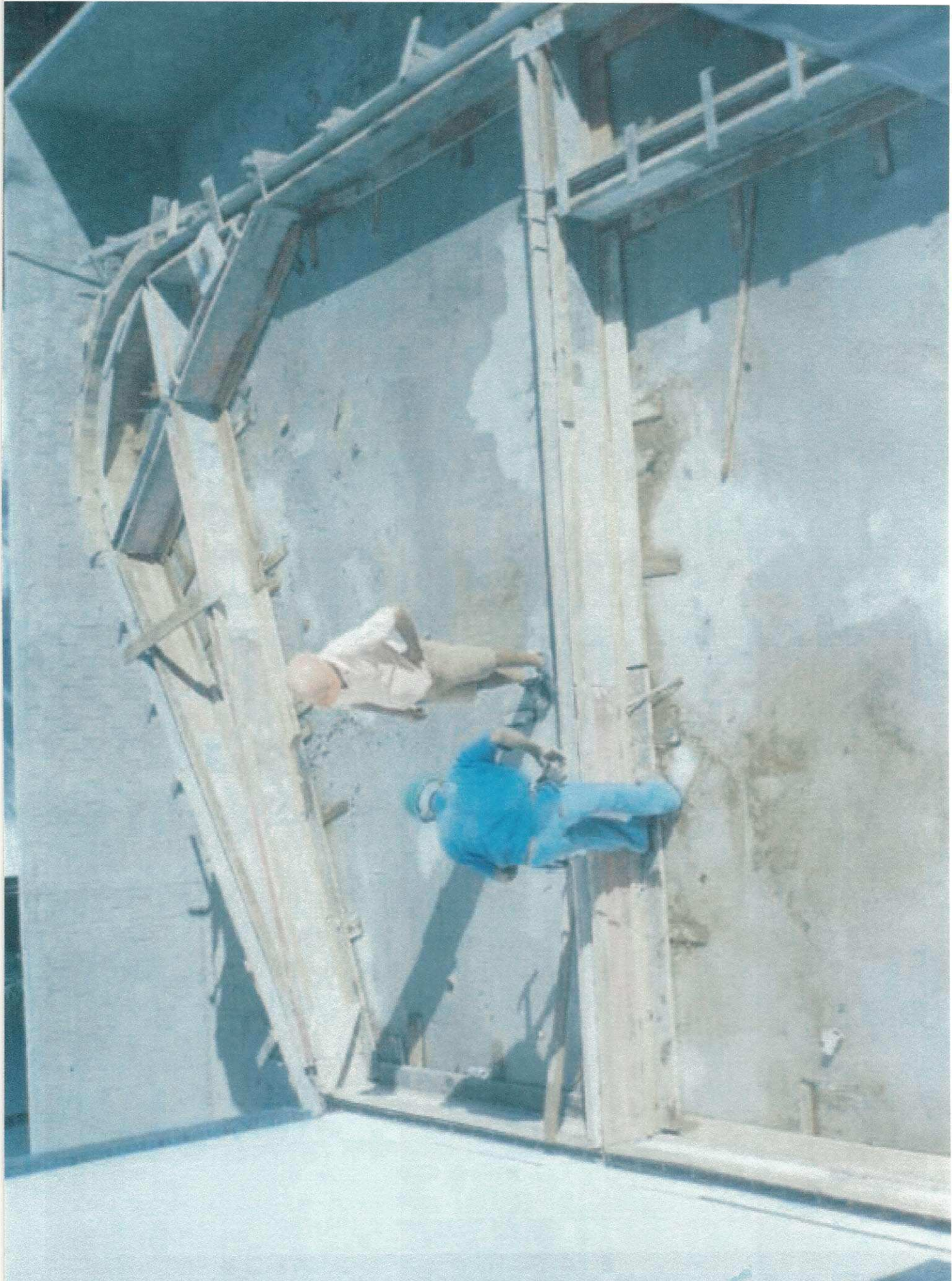
CONCRETEIÇÃO DO DECK
