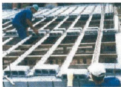
Figura 7.2.2.a e 7.2.2.b Operação de alinhamento das vigotas e painéis treliçados (cortesia Lajes Anhanguera)
