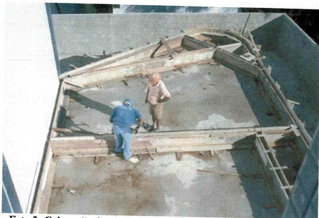
Foto 2: Colocação das formas das vigas da Laje do Deck Autor da Foto: Leonardo Eudes
