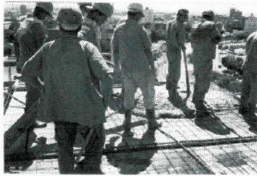
Fig. 7.2.1.d Lançamento do concreto
