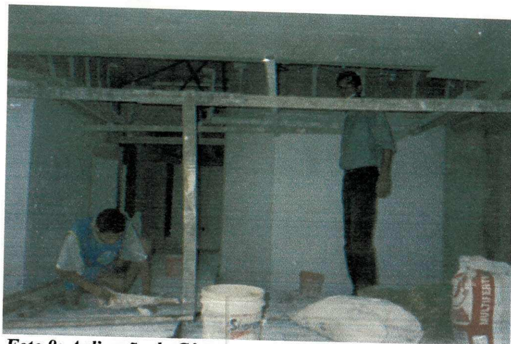
Foto 9: Aplicação de Gesso Autor da Foto: José Carmelo
