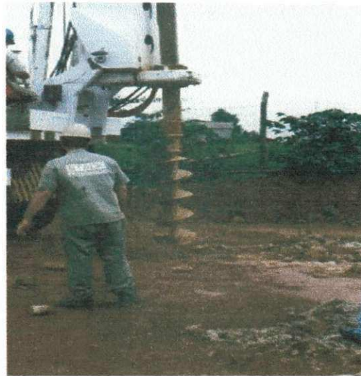
Detalhe do elemento de escavação.
