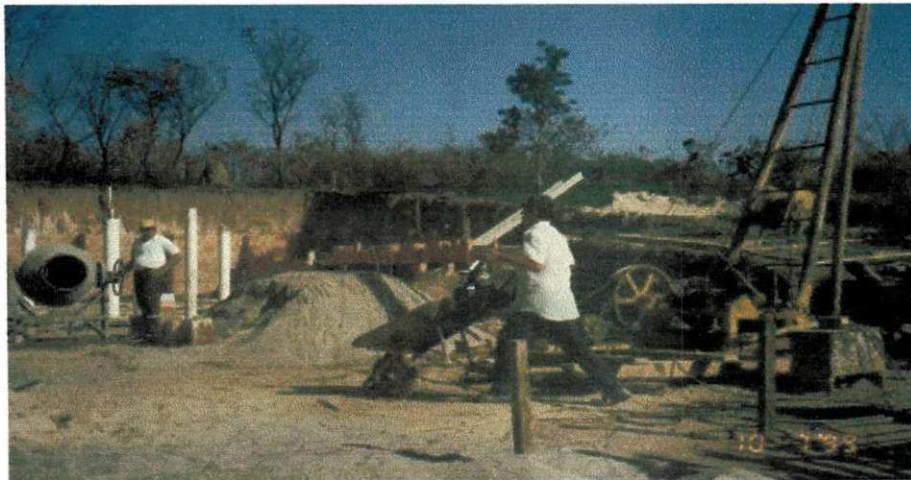
Execução de estaca Strauss.
