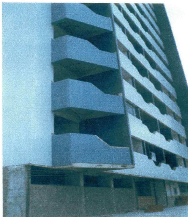
Foto 7: Levantamento de Alvenaria no Mezanino Autor da Foto: Leonardo Eudes
