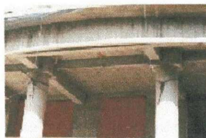
Figura 7.2.1.b Laje maciça e blocos de transição
