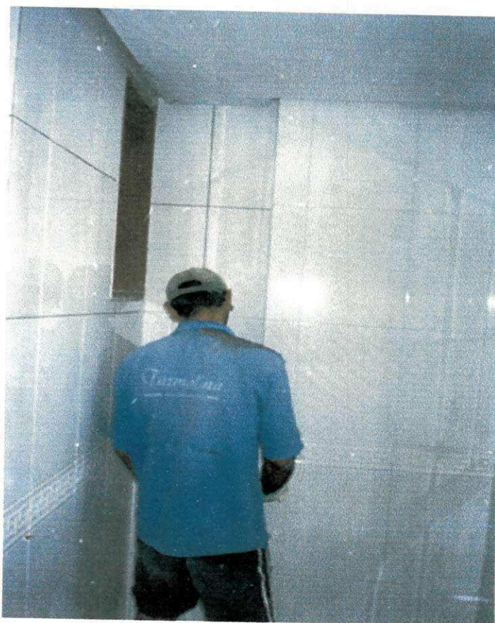
Foto 10: Aplicação do Revestimento Cerâmico Autor da Foto: Leonardo Eudes
