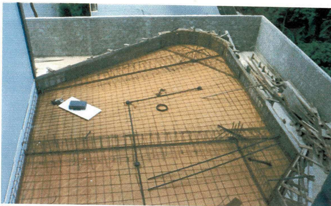
Foto 3: Armação das Ferragens da Laje e Vigas do Deck Autor da Foto: Leonardo Eudes
