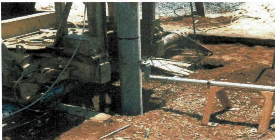
Cravação de estaca pré-moldada.
