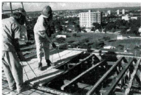
Fig 7.2.1.c Colocação dos elementos pré-moldados
