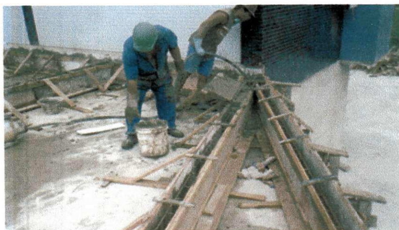
Foto da concretagem das vigas da laje do deck. Autor da Foto: Leonardo Eudes
