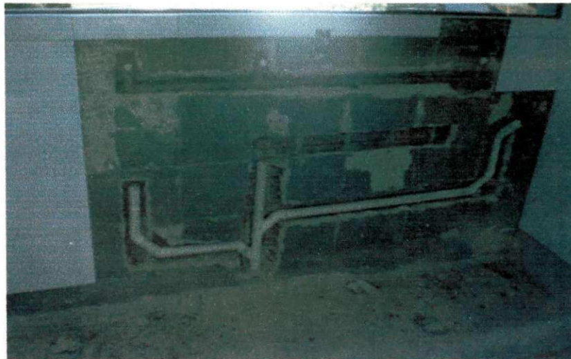
Foto da transferência de pontos da rede de esgoto e abastecimento. Autor da Foto: Leonardo Eudes
