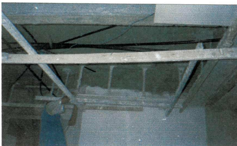
Foto do gesso colocando o revestimento de gesso no teto.
