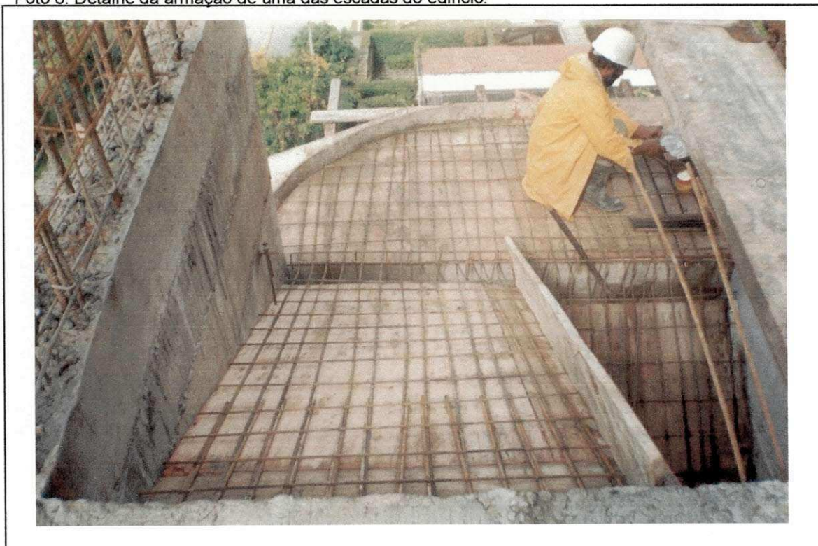
Foto 6: Detalhe da armação de uma das escadas do edifício.
