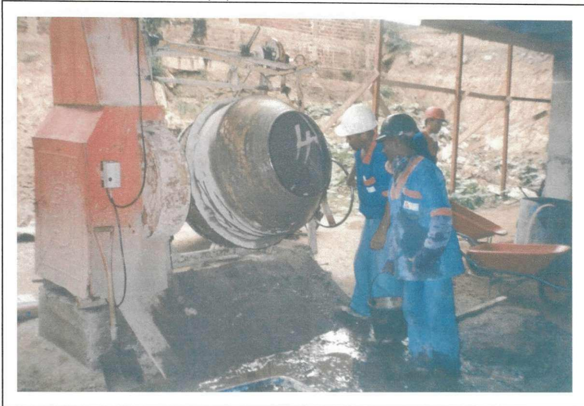
Foto 9: Fabricação do concreto na própria obra.
