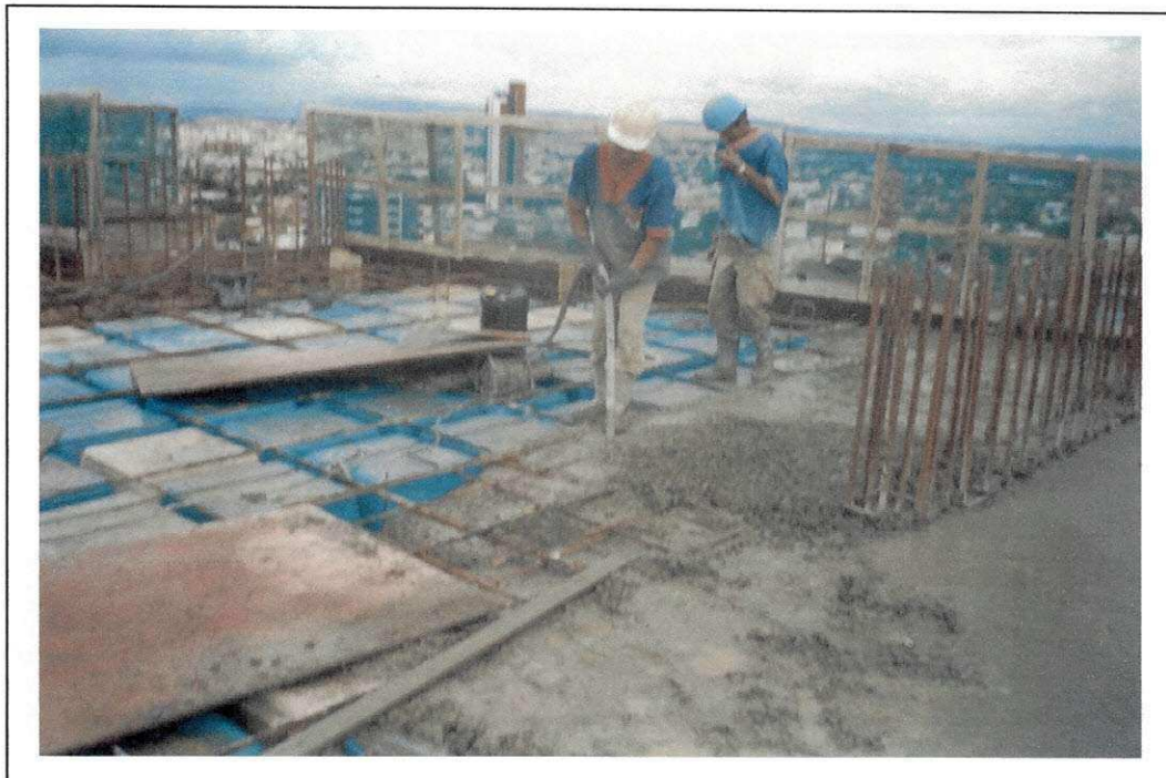
Foto 10: Adensamento do concreto na laje do pavimento 07.
