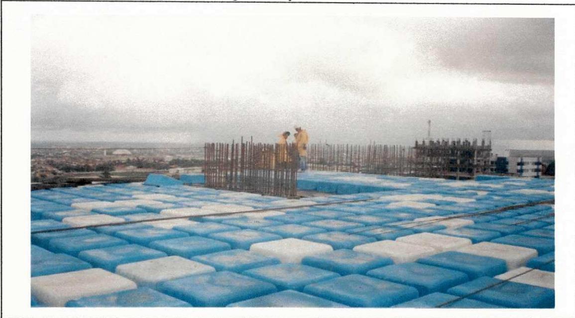
Foto 2: Armação e distribuição das ferragens na laje.
