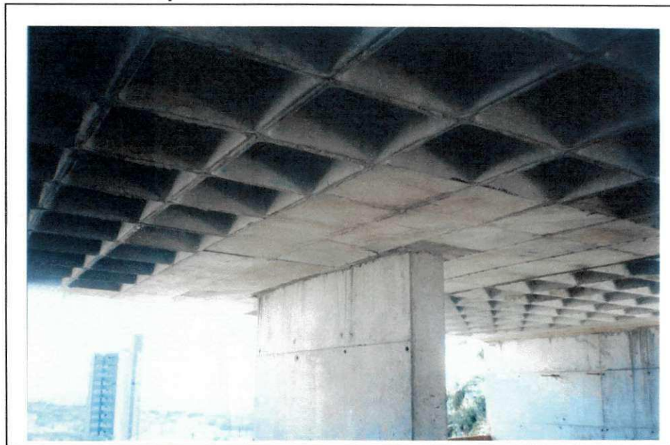
Foto 1: Detalhe da laje nervurada
