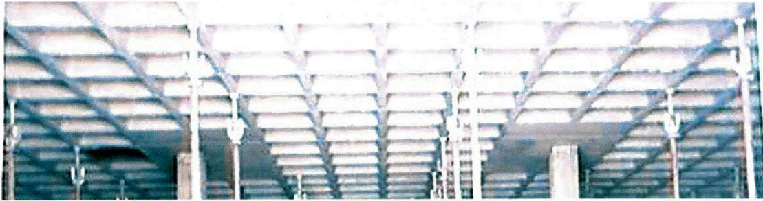
Laje com os escoramentos
