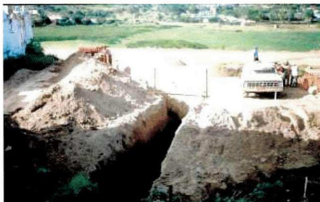
Fig.1- Execução de Drenagem ( Entorno do Açude De Bodocongó)
