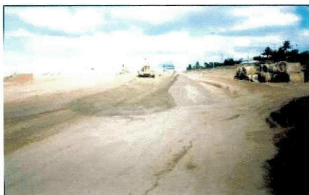
Fig.1- Execução da sub-base da rua perimetral
