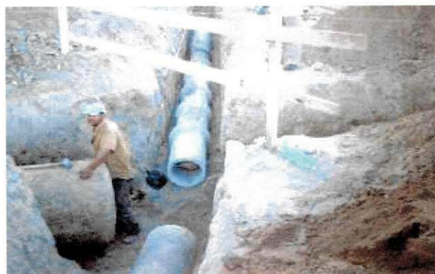
Fig.4 – Detalhe do encontro entre tubos de diferentes dimensões, onde seria instalado caixa de passagem.
