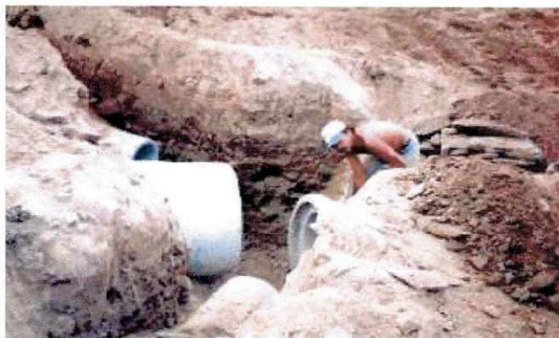
Fig.2 – Assentamento de Tubos
