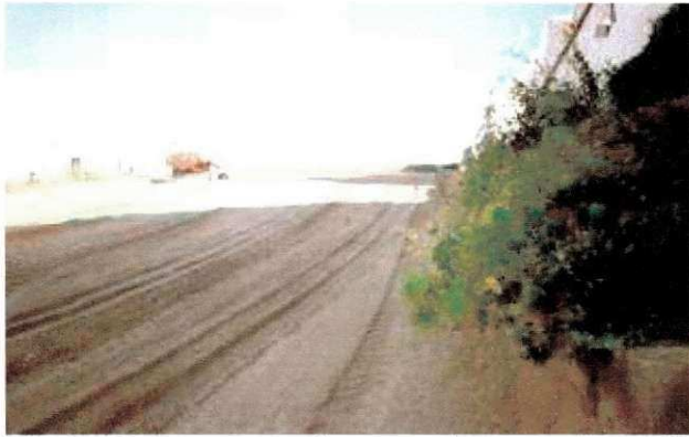
Fig.2 – Compactação do aterro da rua perimetral
