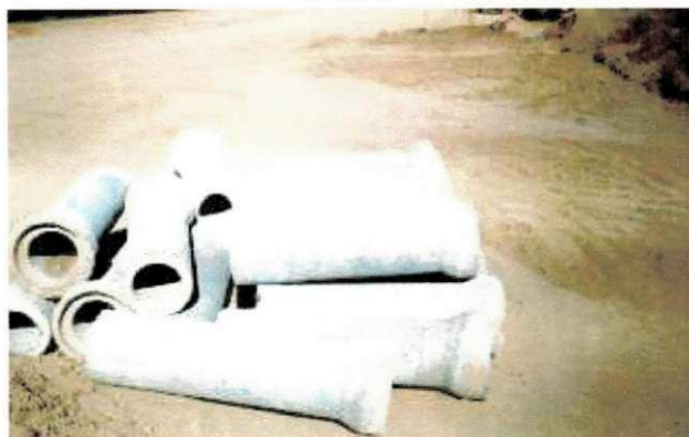
Fig.2 – Tubos Porosos Usados na Obra
