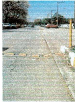
Figura 18: Afundamento em trilha de roda. Nível de severidade alto.
