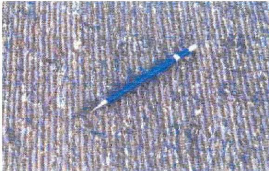
Figura 5 Detalhe de uma pista onde foi executada microfresagem.
